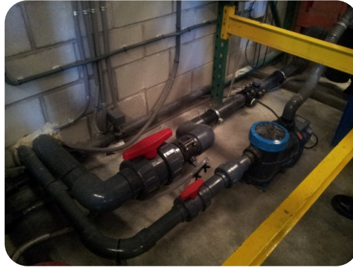
Figura 3.-Tuberías para carga de agua para camión cisterna y para garrafas.
