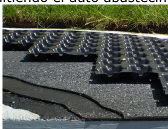
Ilustración 25: Ejemplo de capa drenante Platon De-25. (Fuente: Sánchez-Pando, 2008)
