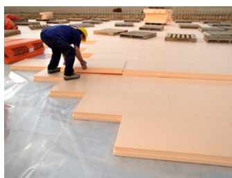
Ilustración 24: Ejemplo de capa aislante. (Fuente: Cemat, 2010)
