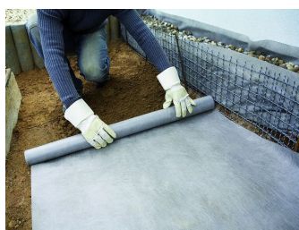
Ilustración 26: Ejemplo de geotextil GEOPROMA®. (Fuente: DUPONT, 2007)
