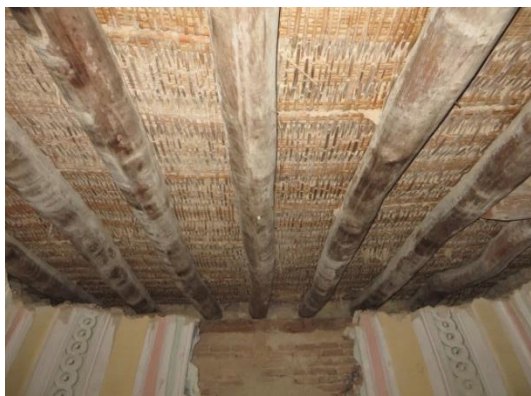
Ilustración 29: Forjado de madera y caña.
