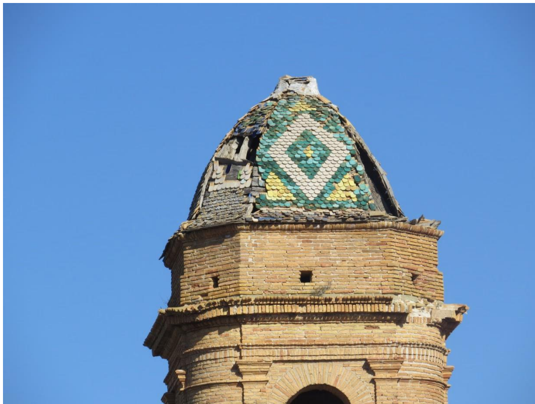
Ilustración 50: Vista de la pérdida de material en la fachada de la torre.
