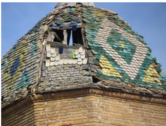
Ilustración 39: Detalle de los diferentes tipos de teja. Se observan las baldosas recortadas en un primer plano.
