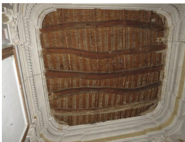
Ilustración 30: Forjado con las vigas en mal estado.
