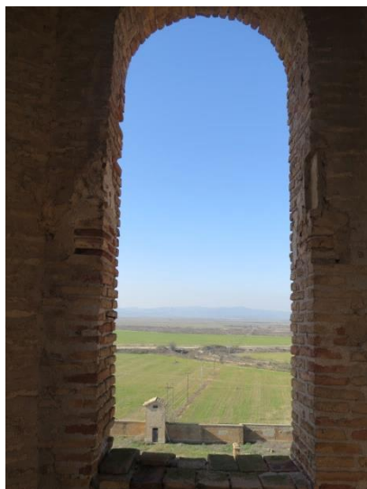
Ilustración 22: Detalle de una ventana con los ladrillos erosionados.
