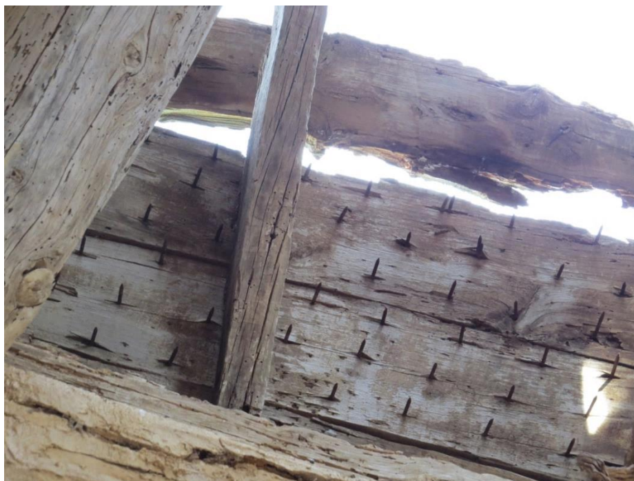
Ilustración 45: Detalle de las tablas de sujeción con los clavos.
