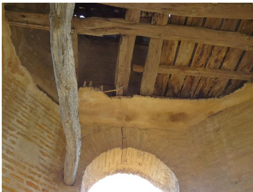
Ilustración 17: Detalle de grieta en la que se observa como "busca" el material más blando (la junta).
