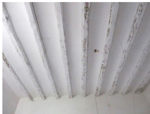
Ilustración 28: Forjado cubierto de yeso.
