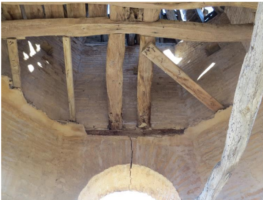
Ilustración 16: Detalle de grieta en la clave del arco de una de las ventanas.
