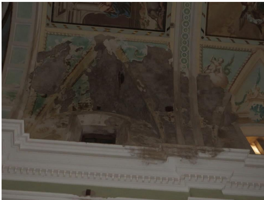
Ilustración 47: Pérdida de material en la bóveda más próxima a la torre.
