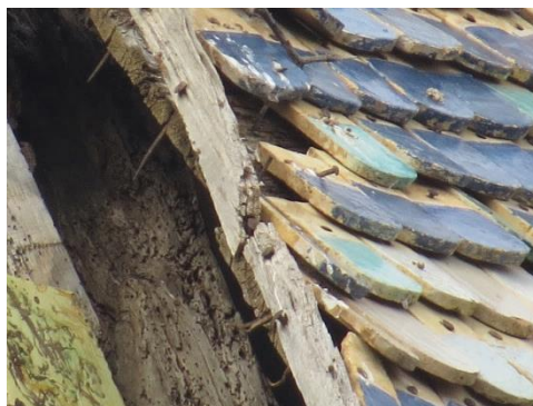
Ilustración 38: Detalle del sistema de sujeción de las tejas.
