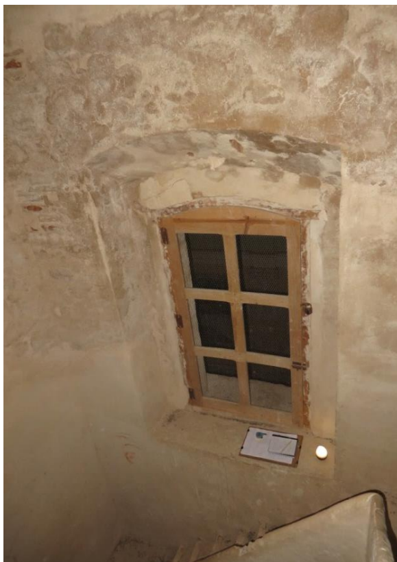
Ilustración 48: Ventana este de la torre, se aprecian las manchas de humedad y eflorescencias.
