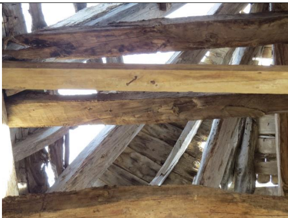
Ilustración 32: Detalle de las vigas de la estructura del chapitel.
