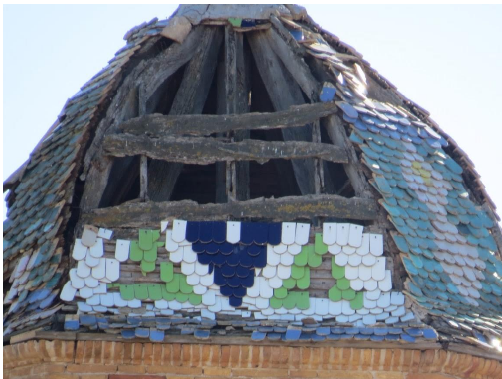
Ilustración 44: Vista del estado de las tablas de sujeción de las tejas.
