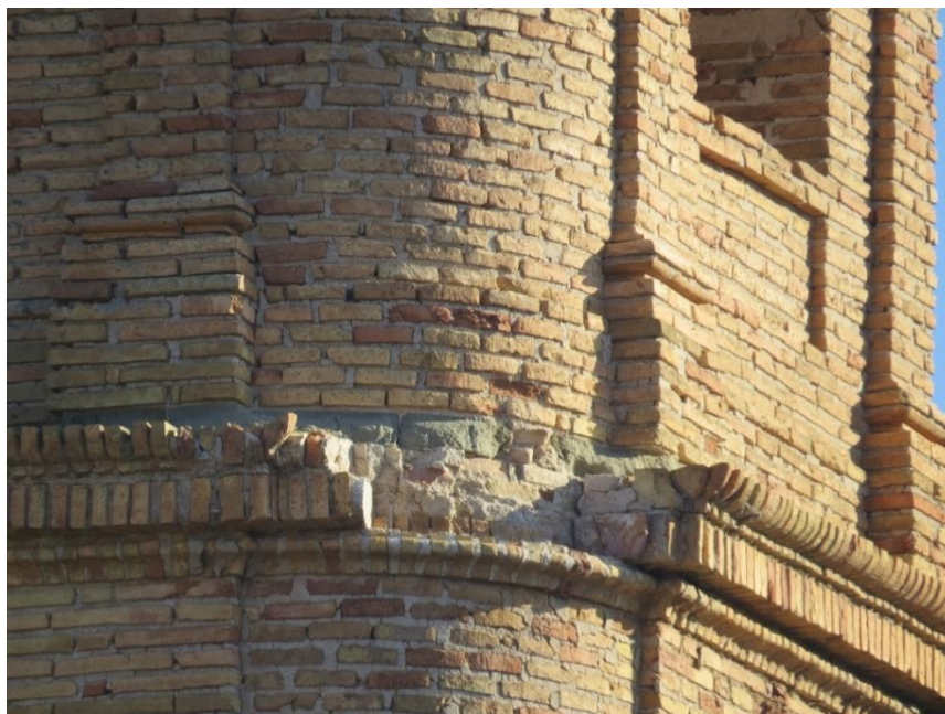
Ilustración 51: Detalle de la pérdida de material.
