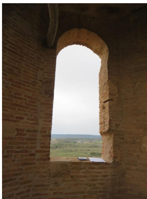
Ilustración 23: Detalle de la ventana Sur. Se observan los "parques" de mortero
