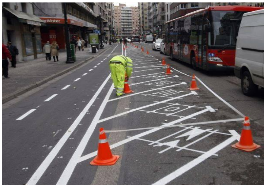
Ilustración 5: FIG 2.5 Construcción de carril bici en Coso medio.
