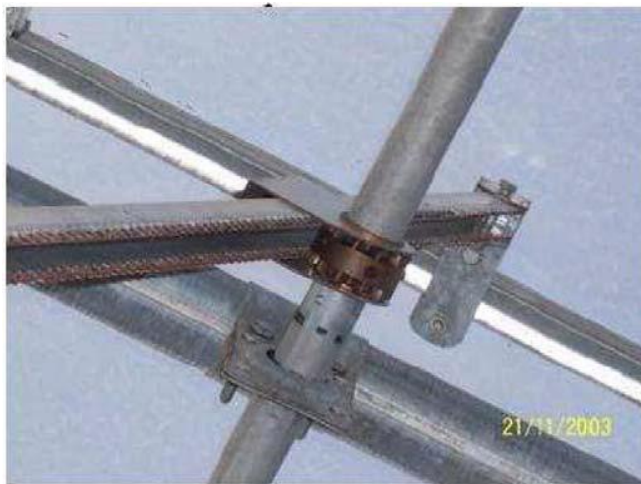
Figura 21: detalle de la cremallera para apertura de ventilación.
