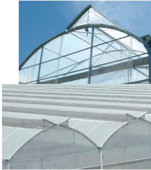
Figura 19: detalle de ventilaciones cenitales de tipo supercénit y mariposa.
