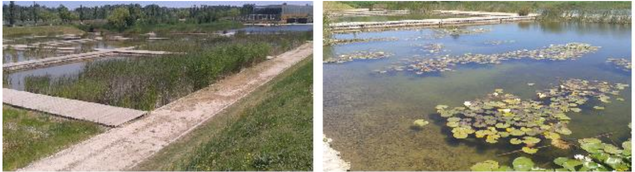
Figura 20: Humedal artificial con función de depuración.
