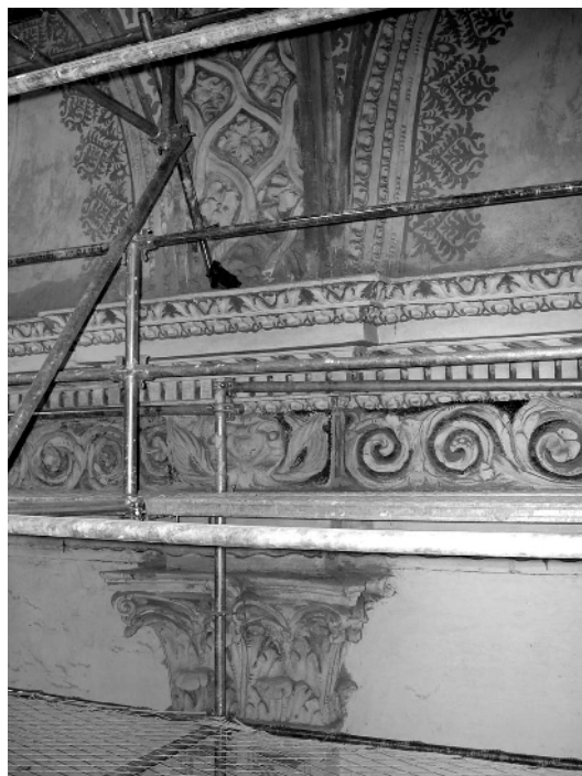
Sacristía de la iglesia del Real Monasterio de Santa María de Veruela. Detalle de la decoración en yeso policromado (en restauración).
