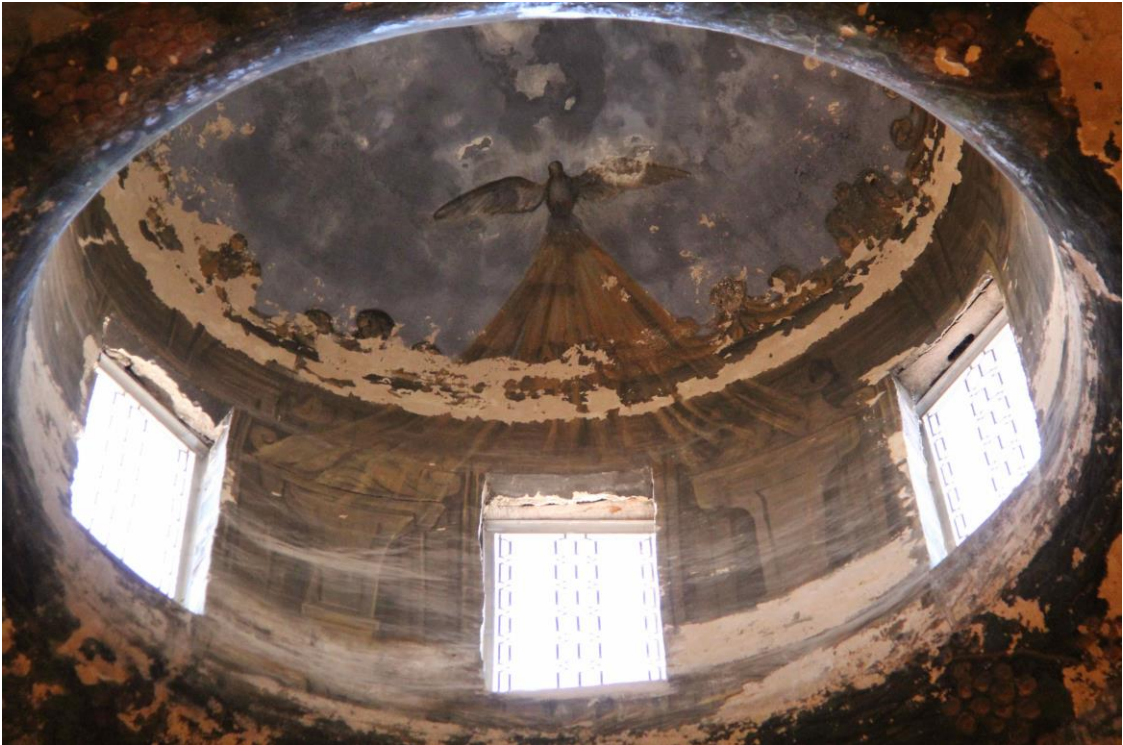
Fig. 30 Detalle de la linterna de la cúpula del presbiterio con la representación del Espíritu Santo. Foto: Blanca Aranda Rubio, 31/03/2015
