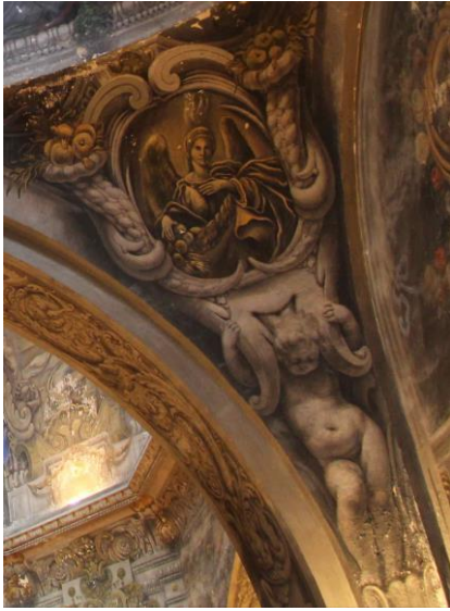
Fig. 12 Pechina del segundo tramo Foto: Blanca Aranda Rubio, 31/03/2015
