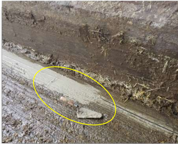
Figura 12. Cable tapado de cemento en la ranura.
