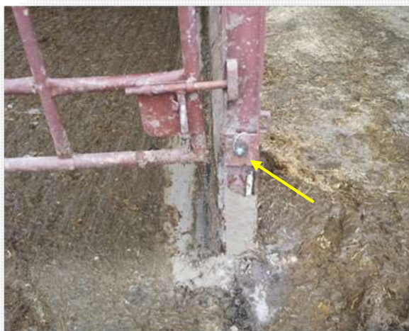
Figura 13. Cable de hierro fijado en la cordinaza.
