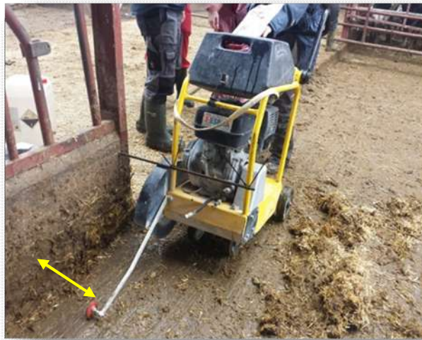
Figura 10. Ranura a distancia de 20 cm de la pared de los comederos.
