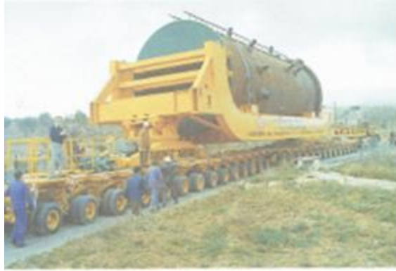
Transporte de la vasija y maniobra de durante el montaje.
