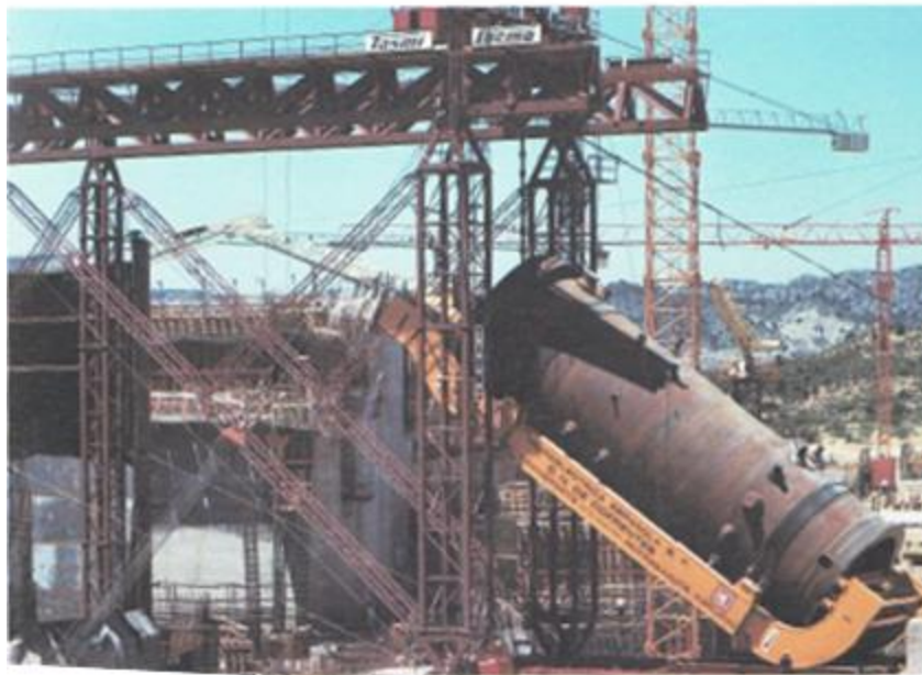
Transporte de la vasija y maniobra de durante el montaje.
