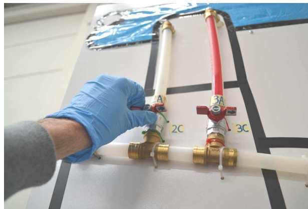
Figura 23. Comprobación agua limpia, llave d2 (Fig.18) posición cerrada C.
