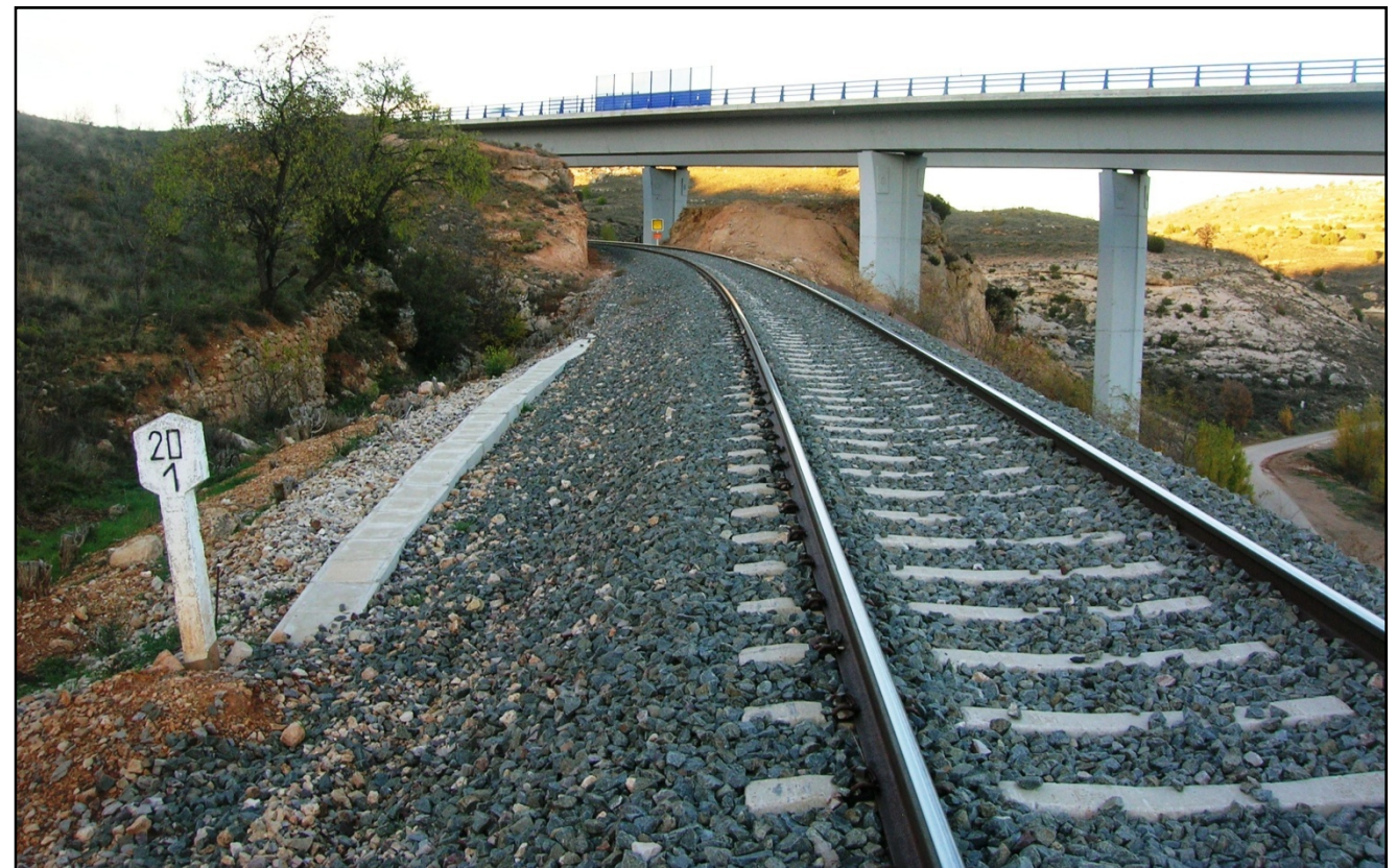
Ilustración 12. PK 20+100 en terraplén, con servicios eléctricos en base talud de banqueta.
