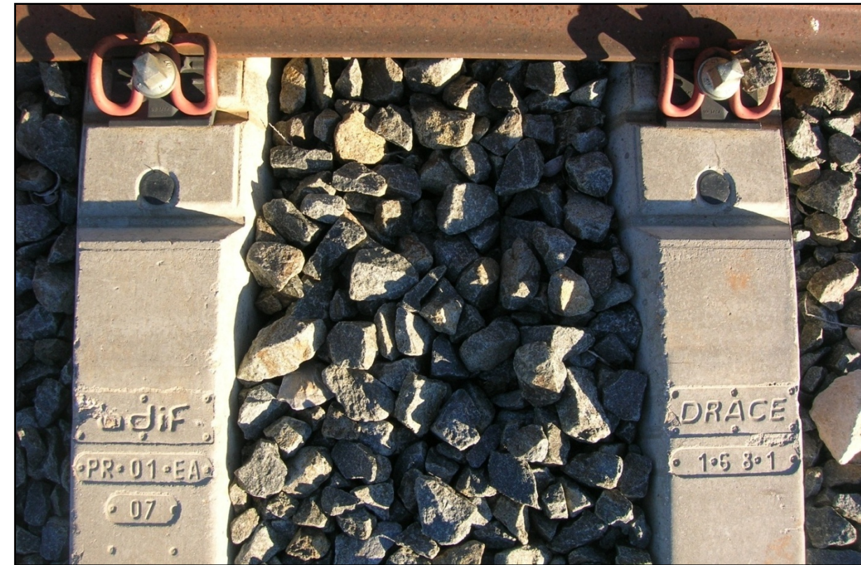
Ilustración 5. Actuales traviesas PR-01 en buen estado. PK 28+900.
