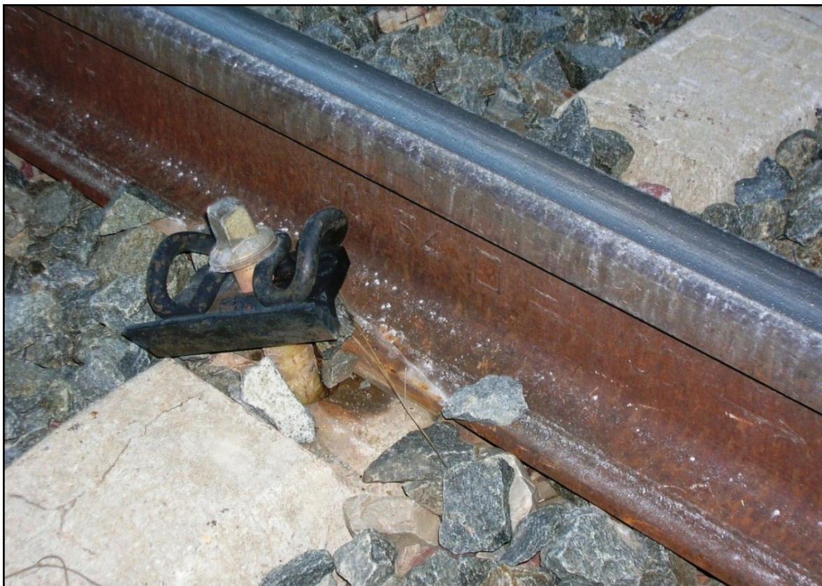
Ilustración 4. Estado de sujeciones Vossloh con carril-54 E1 y traviesas PR-90 fisuradas.
