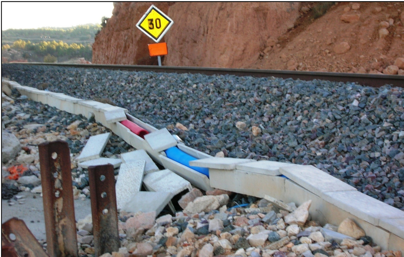
Ilustración 10. Servicios eléctricos sin protección y al descubierto. Sentido Teruel.
