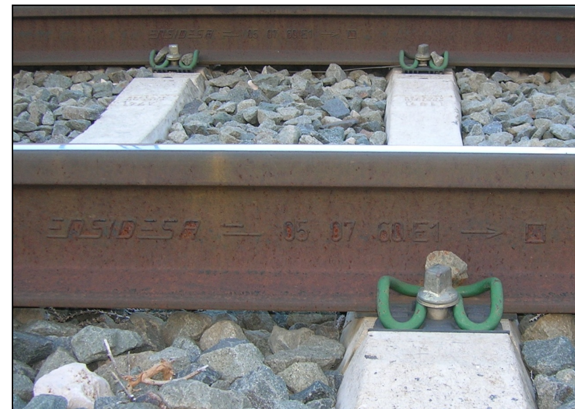
Ilustración 6. Carril 60 E1 (año 2.007) en estado de conservación aceptable. PK 28+900.
