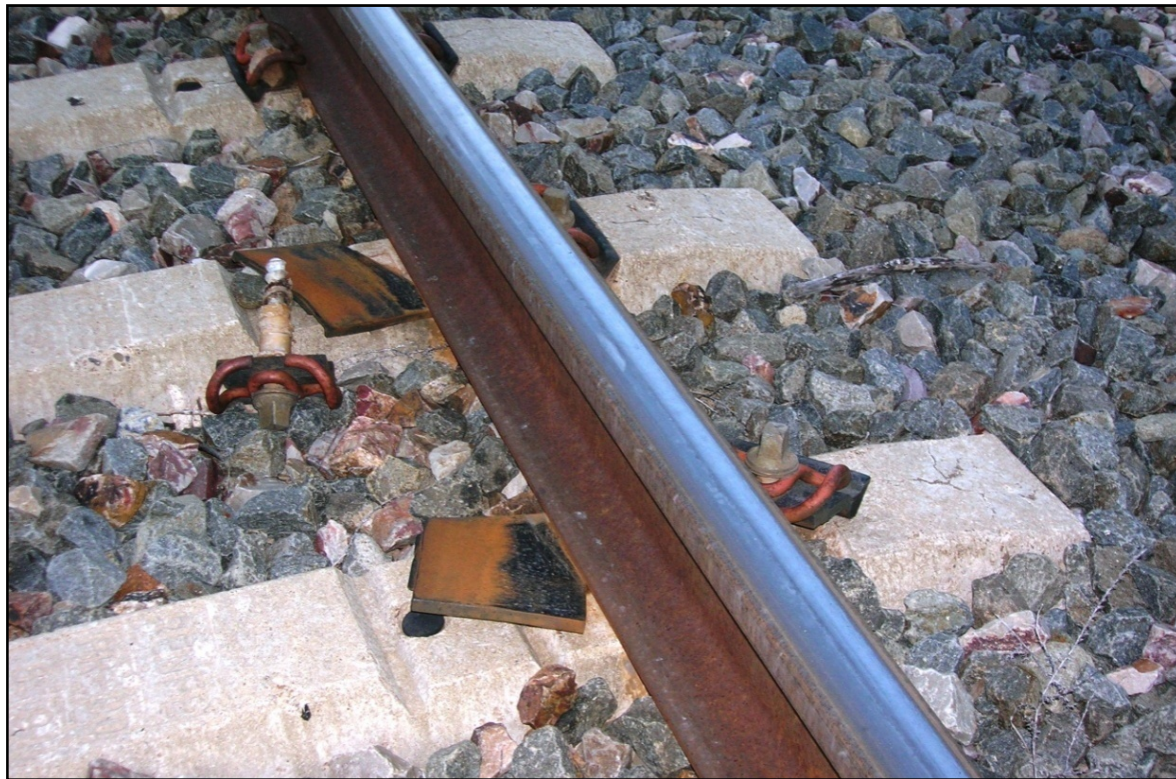
Ilustración 3. Sujeciones elásticas y placas de fondo completamente desarmadas. PK 20+350.
