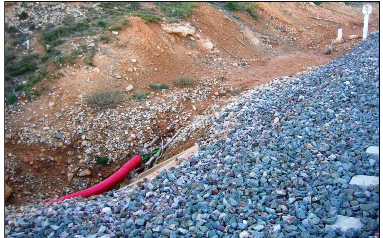
Ilustración 11. Paso de líneas eléctricas sin protección por un emboquille de ODT.
