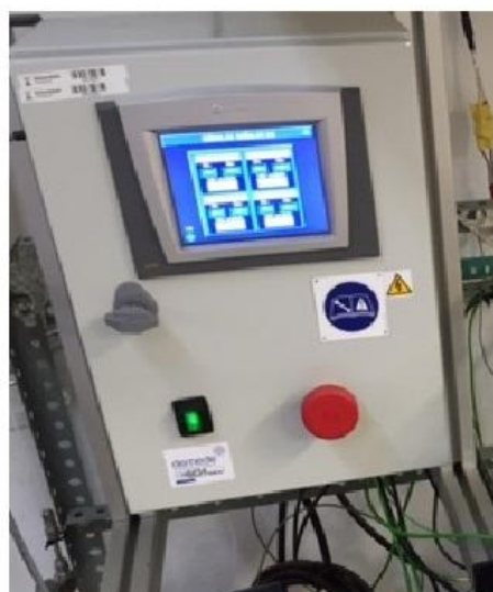
Figura I.3. Sistema de control y monitorización central (PLC)
