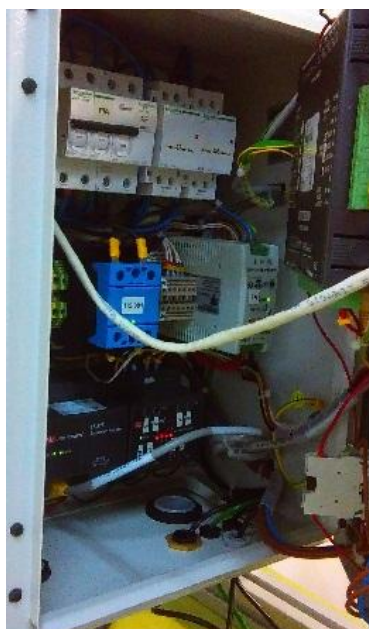
Figura I.3. Sistema de control y monitorización central (PLC)
