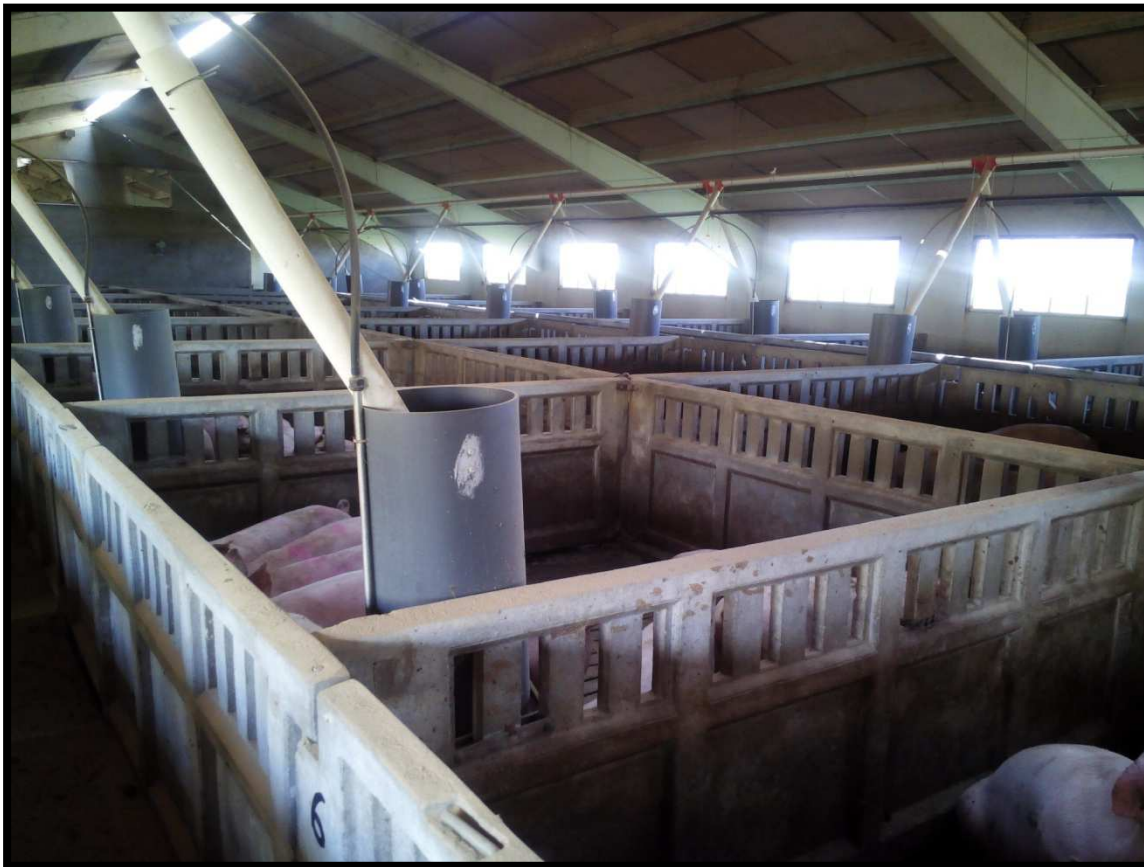
Ilustración 2. Distribución de las celdas, mediante tabique prefabricados de hormigón.
