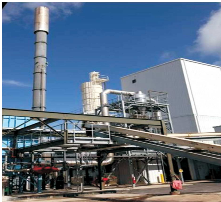
Figura 12: Planta piloto de pirólisis catalítica de la madera de Kior (USA).
