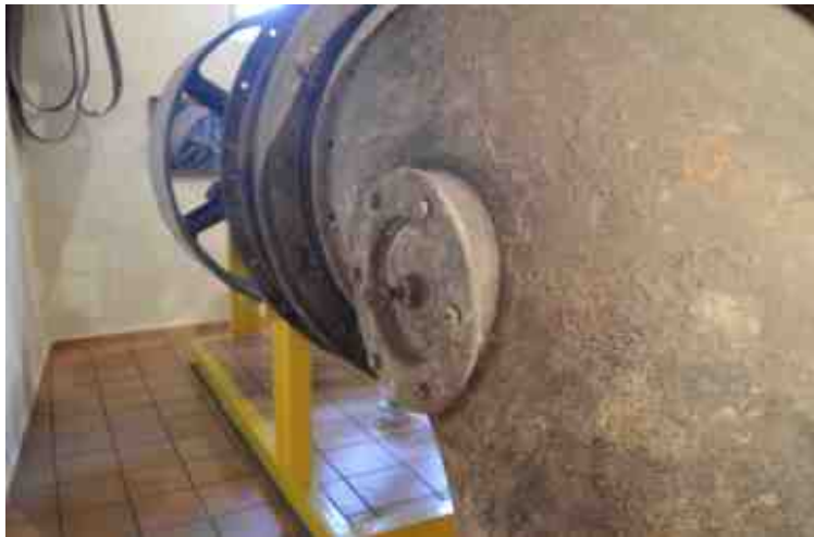
Detalle de la compuerta de limpieza del conducto de salida de agua
