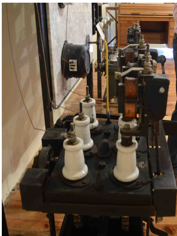
Protección contra sobretensiones por relé, rearmable.
