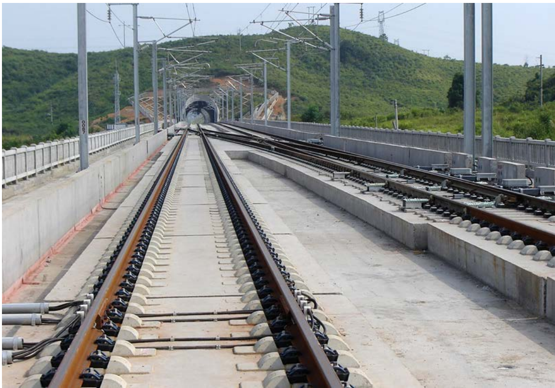
Figura 3-3: Vía en placa con desvío (línea Wuhan-Guangzhou).
