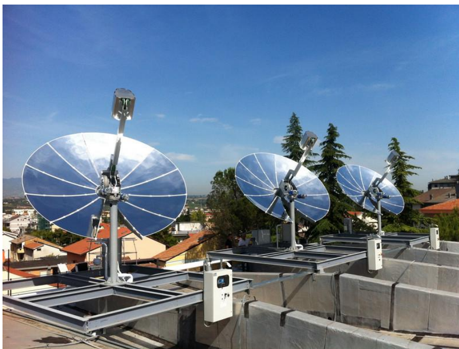
Figura 18: Instalación de varios discos Stirling en serie para cubrir una demanda colectiva.
