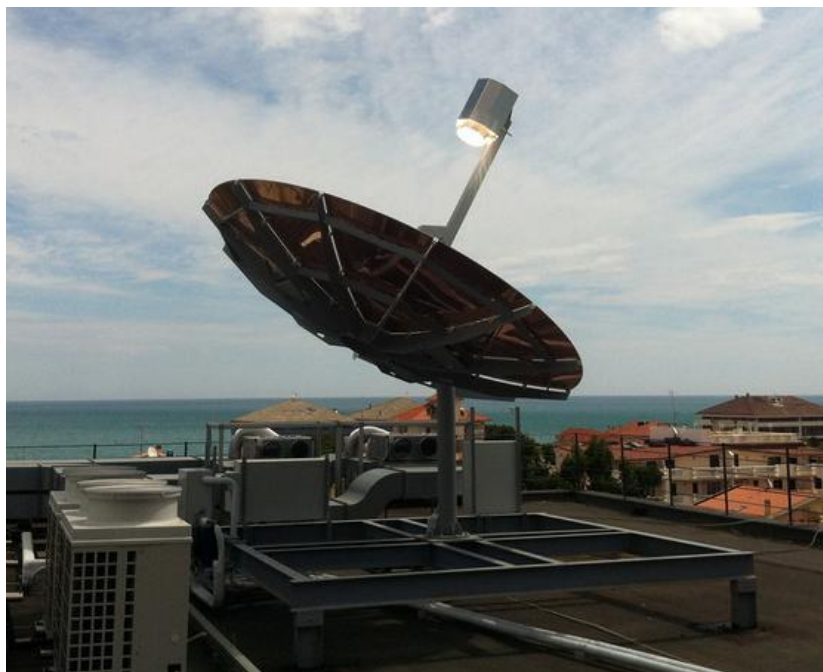
Figura 12: Sistema de disco Stirling montado sobre estructura metálica.
