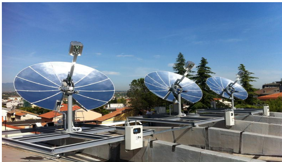
Figura 1: Instalación de varios sistemas de disco Stirling Trinum en serie para cubrir una demanda colectiva.
