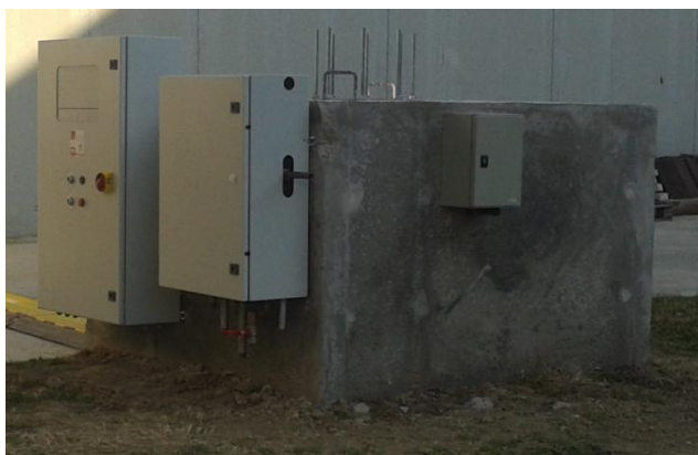
Figura 45: Colocación de los cuadros en el dado.
