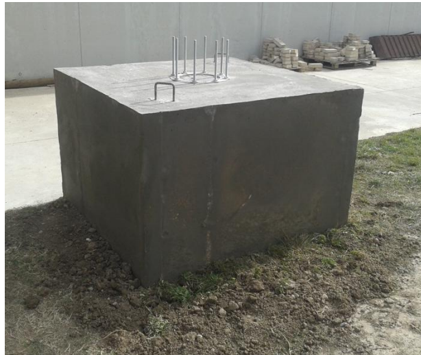
Figura 43: Dado de hormigón acabado.
