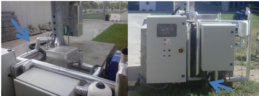
Figura 23: Líneas eléctricas entre los distintos elementos.
