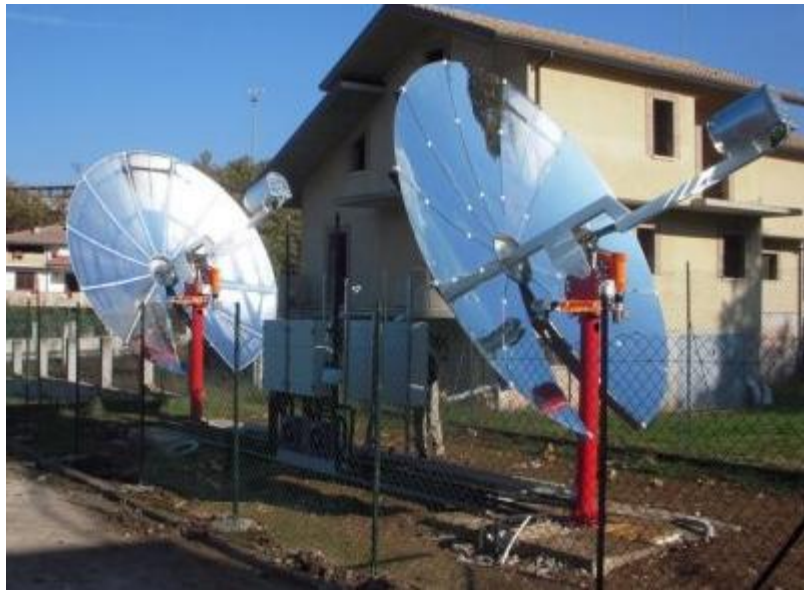
Figura 13: Sistema de disco Stirling montado sobre zapata de hormigón semienterrada.
