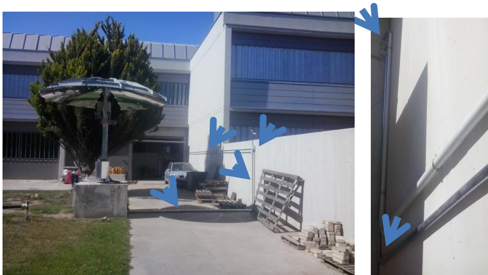
Figura 22: Instalación eléctrica desde la nave hasta el sistema de disco Stirling Trinum.
