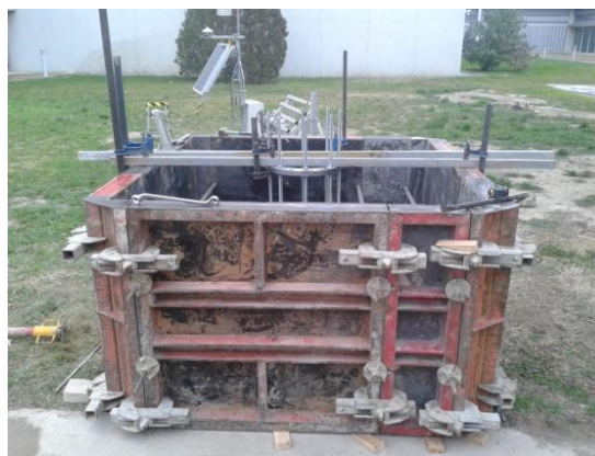
Figura 41: Encofrado del dado.
