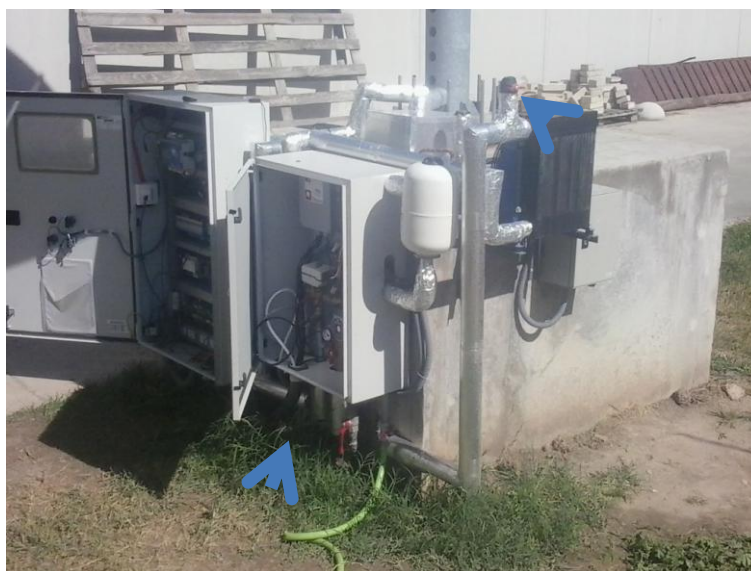
Figura 56: Posición de las válvulas de vaciado.
