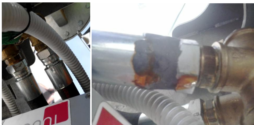
Figura 54: Fuga y sellado de la misma respectivamente.
