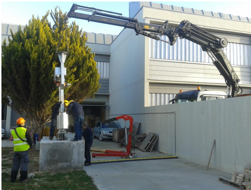
Figura 47: Izado de la columna del sistema de disco Stirling Trinum.
