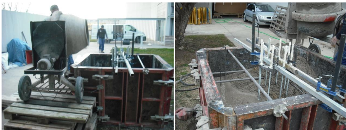
Figura 42: Vertido del hormigón.
