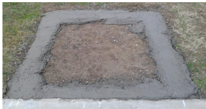
Figura 40: Preparación de la solera.
