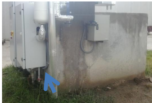
Figura 24: Línea desde el cuadro hidráulico hasta el dissipador.
