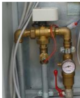
Figura 57: Válvula de tres vías.
