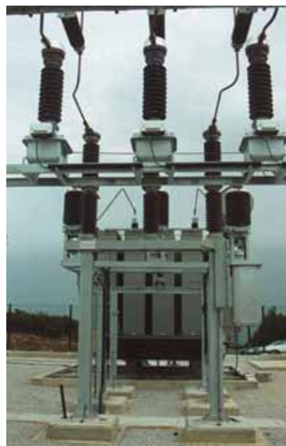
Transformadores de Tensión Inductivos de 72,5 kV en Parque eólico. Iberdrola (España).
