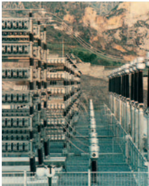
Transformadores de Intensidad de 123 kV protegiendo banco de condensadores en interconexión de corriente continua (H.V.D.C.). Diseñada por Siemens Alemania para Sate Power South Co. (China).
