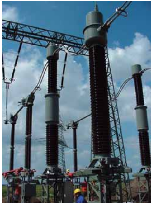
Transformadores de Intensidad y Tensión Inductivos de 420 kV. Vattenfall Transmission (Alemania).
