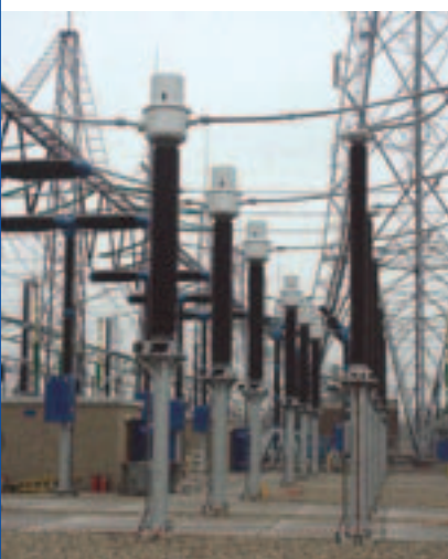
Transformadores de Intensidad de 420 kV en entrada de bancos de condensadores. Tennet (Holanda).
