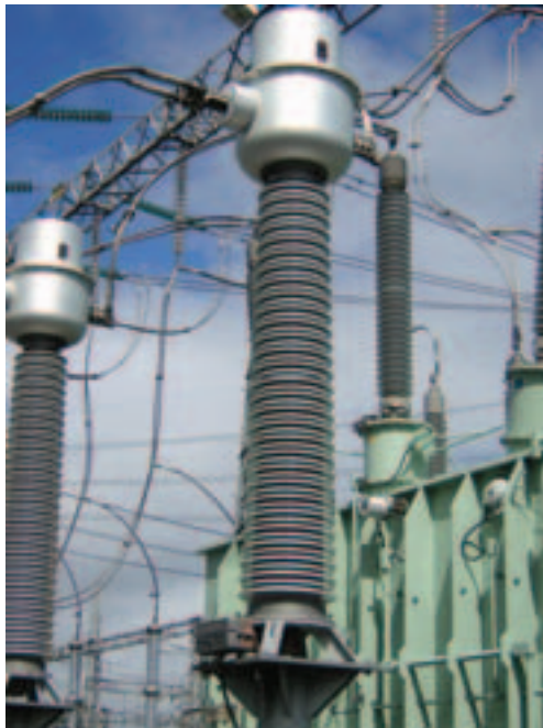
Transformadores de Intensidad de 245 kV para protección de transformadores de potencia con diseño especial antisísmico. Transpower (Nueva Zelanda).
