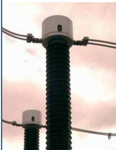
Conexión de "paso de corriente" en Transformadores de Tensión Inductivos de 245 kV.
