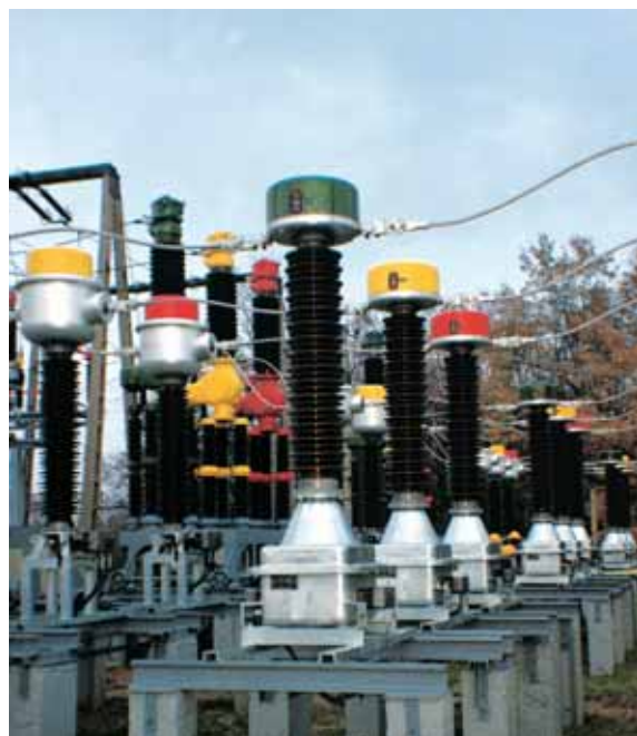
Tranformadores de Tensión Inductivos de 123 kV. MVM (Hungría).
