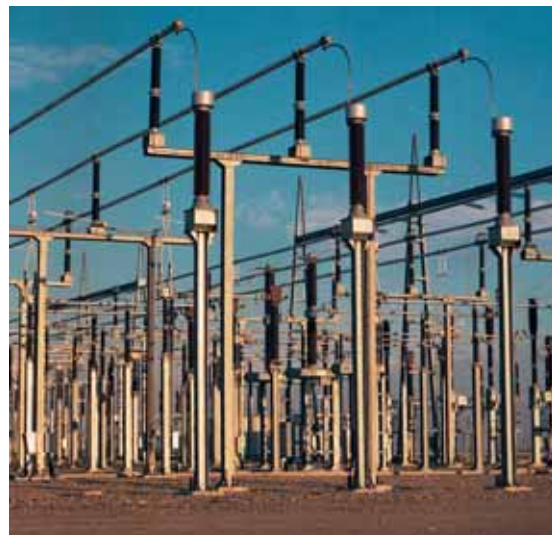
Transformadores de Tensión Inductivos de 245 kV. Red Eléctrica de España (España).
