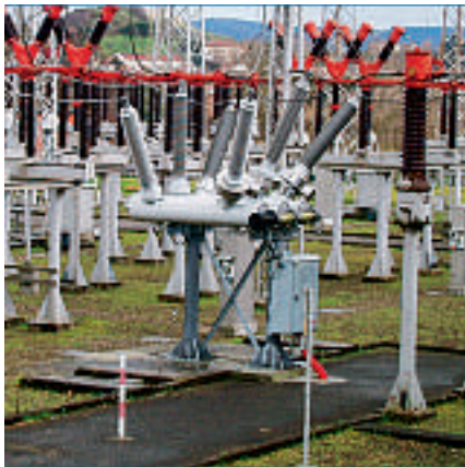
6 Contactos móviles DS integrados en el interruptor automático
