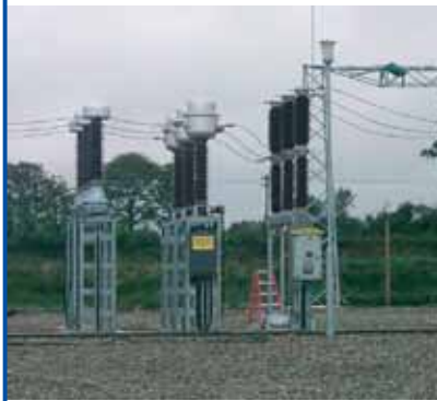
Transformadores de Intensidad y de Tensión Inductivos de 123 kV. ESB (Irlanda).
