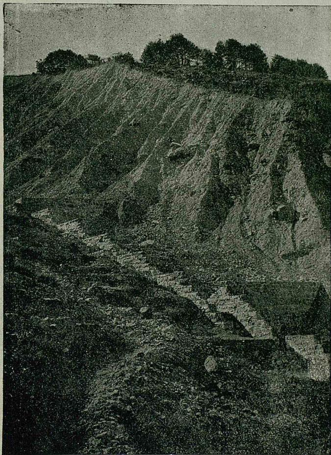
a-a-a Cresteñas de una de las erosiones de la ladera izquierda del torrente «Los Meses», que proporcionaban los materiales sólidos que soterraban a la villa de Canfranc, a la carretera de Jaca a Francia y a las fincas que se ven en la fotografía anterior. b-b-b Un tramo canalizado en la cuenca de recepción del torrente.
