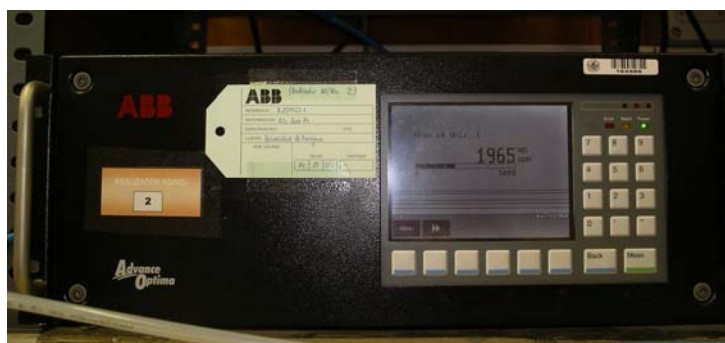
Figura B.15. Analizador CO/CO 2
