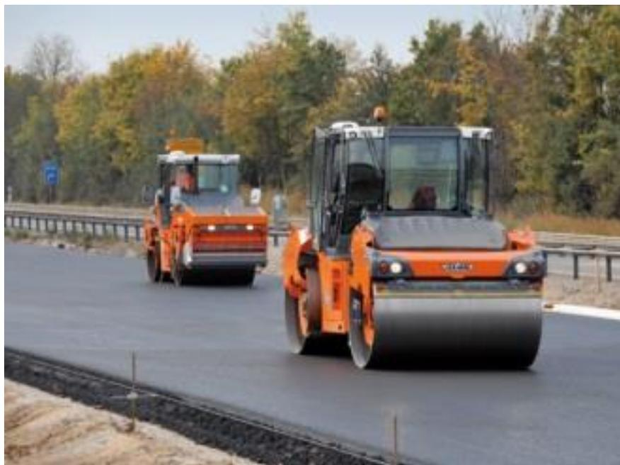
Rodillos compactadores pasando sobre capa aglomerado asfáltico.
