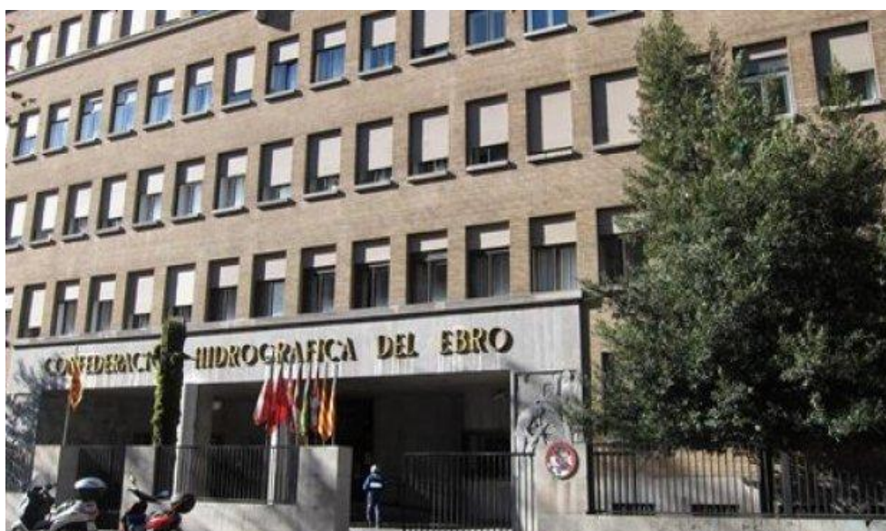
Foto 1. Edificio de la Confederación Hidrográfica del Ebro. Fuente: www.iagua.es
