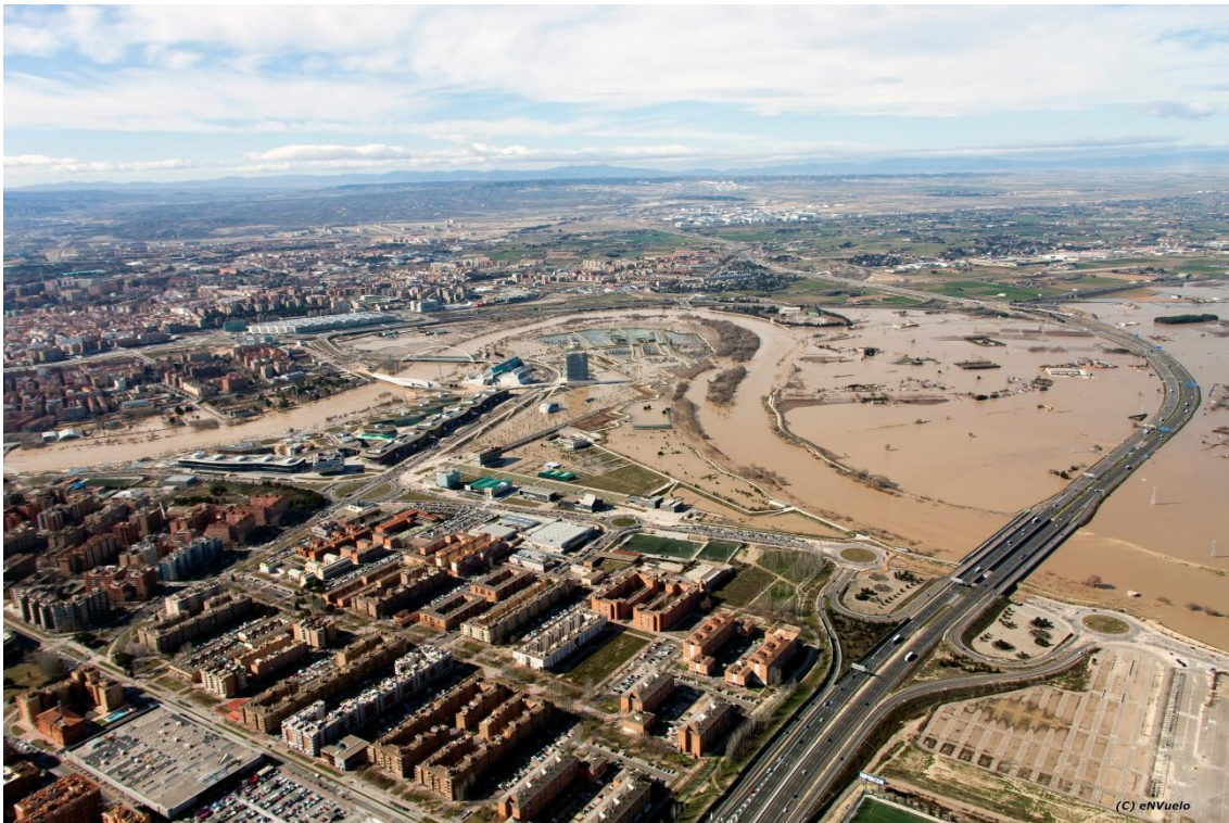
Foto 5. Imagen aérea (02/03/2015) de las inundaciones a su paso por el núcleo poblacional de Zaragoza. Fuente:CHE
