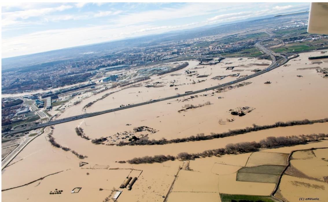
Foto 7. Autovía A-2 a su paso por Zaragoza (Zona Expo) el día 02/03/2015. Fuente: CHE
