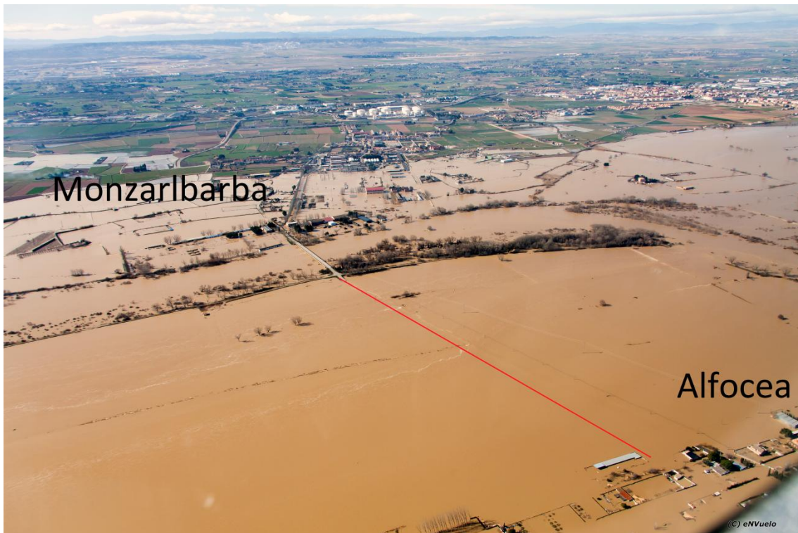
Foto 6. Imagen aérea (02/02/2015) de la carretera cortada entre Monzalbarba y Alfocea. F
