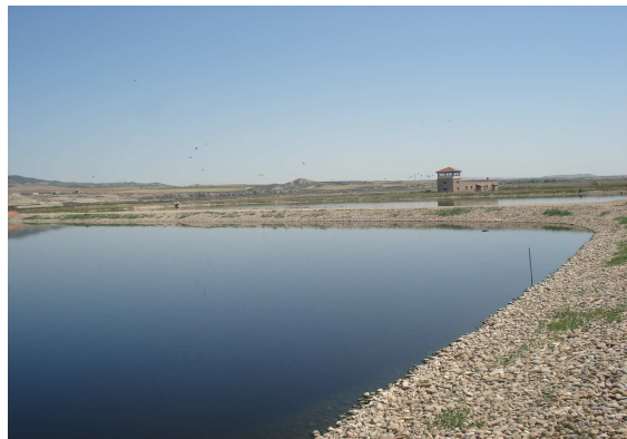
Figura 3.3: Laguna aerobia como tratamiento terciario.
