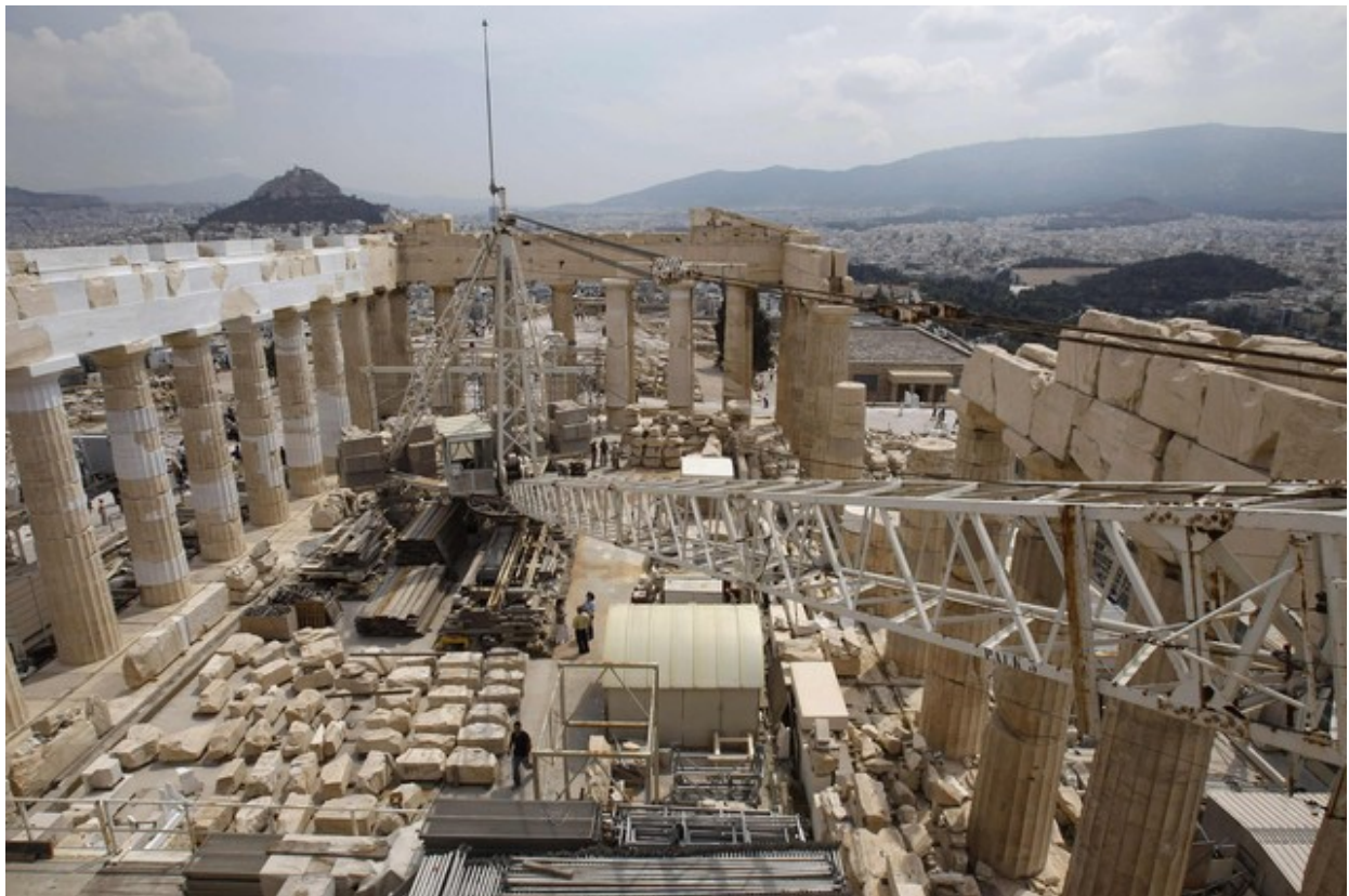
Ilustración 11: Interior del Partenón en el proceso de la restauración.
