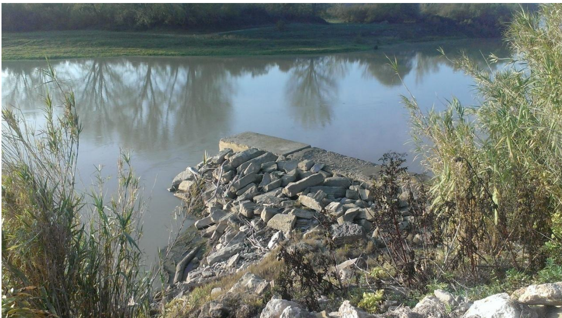
Foto 23. Espigón en el que podrían hacerse una mejora, retirando parte de los bloques. Autor: Sara Salas
