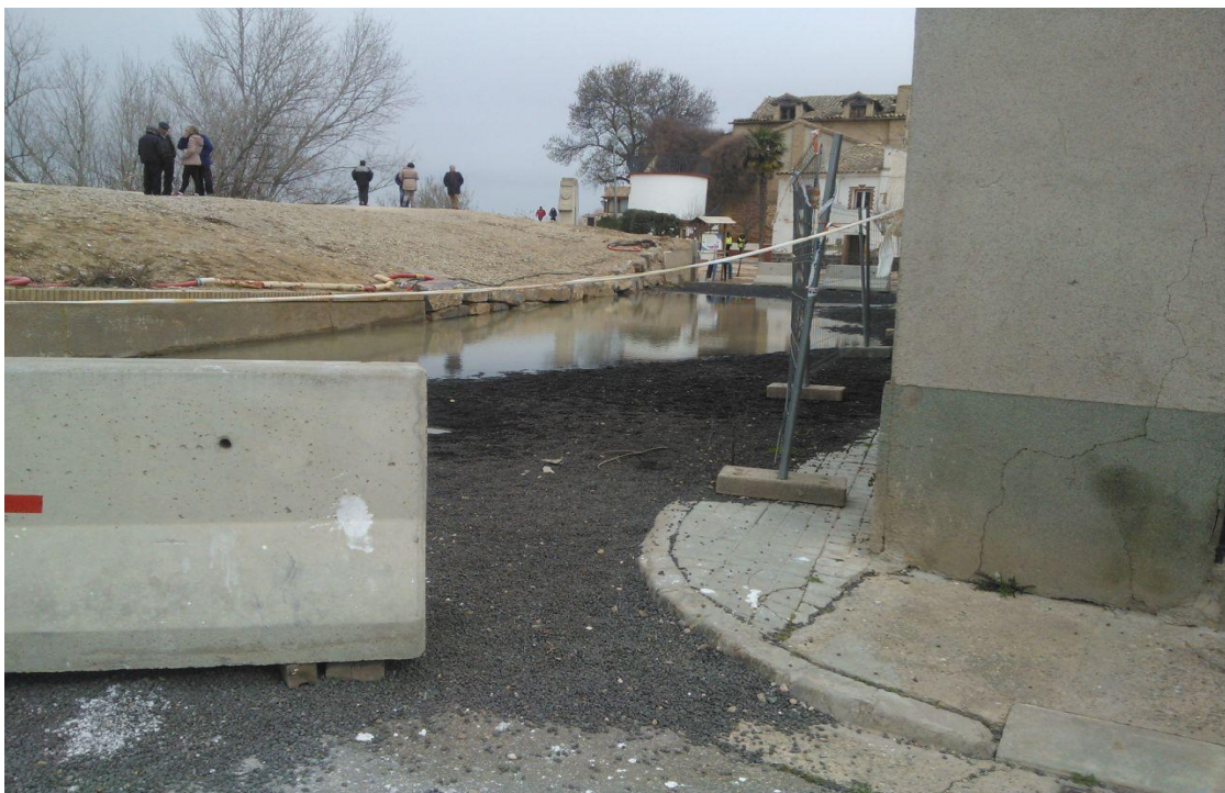
Foto 25. Estado de la calzada y la mota en la última avenida de Febrero de 2015. Autor: Sara Salas
