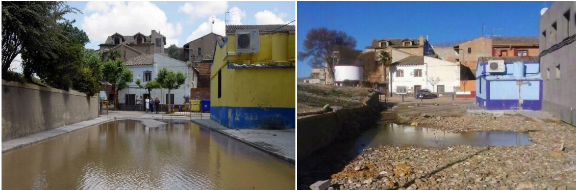
Foto 4 y 5. Aspecto de la calle y muro en el año 2006 y en el año 2014. Se observa cómo ha habido un deterioro de la mota de defensa y se ha generado un punto de debilidad en la misma. Fuente: Heraldo y Sara Salas
