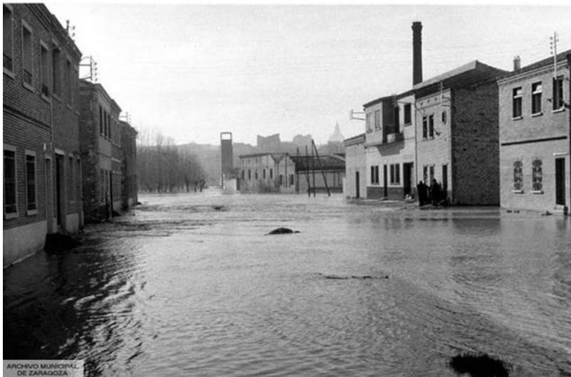
Foto 14. La calle de la Ortilla inundada. Al fondo, la torre de Helios y la chimenea de la fábrica de tratamiento de lanas, ambas existentes hoy. Fuente: Proyecto "GAZA"
