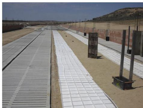
Instalación de suelo radiante en una granja de porcino de cebo en construcción
