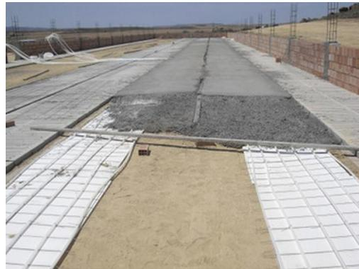
Hormigonado de la solera con los tubos dentro.
