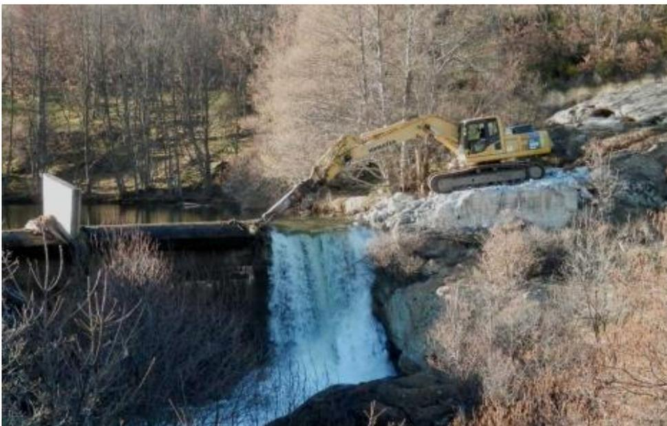
**Ilustración 3 : Demolición presa Umbrias en Ávila, año 2013.**
