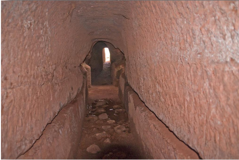
Tramo del canal del Acueducto de Tiermes, próximo a la “Casa del Acueducto”. Archivo del Museo Numantino.
