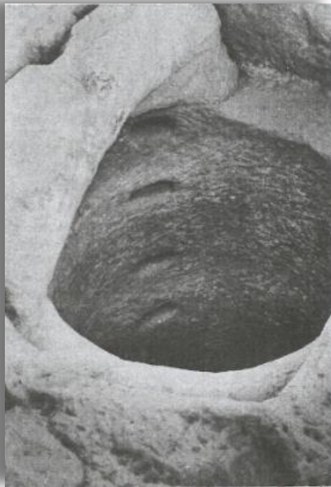
Registro número 1 del canal subterráneo del acueducto de Tiermes (ARGENTE OLIVER, 1981: 7)
