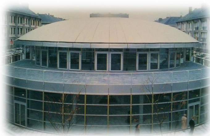
Imagen 7: Extremo del centro comercial, donde se aprecian las fachadas y la cubierta.
