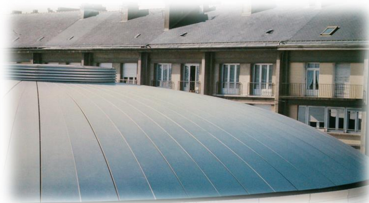
Imagen 6: Cubierta del centro comercial.
