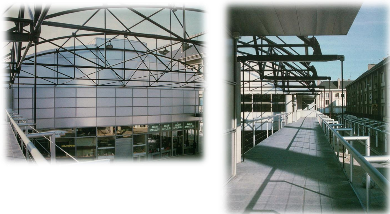
Imágenes 4 y 5: Fotografías de la zona central de la estructura y las pasarelas.
