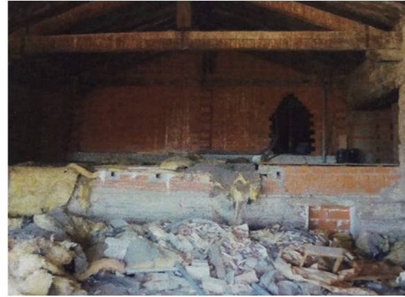
Figura 92. Espacio bajocubierto antes.
