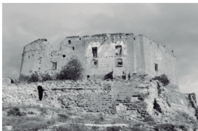
Figura 16. Castillo de Argavieso [estado actual].
