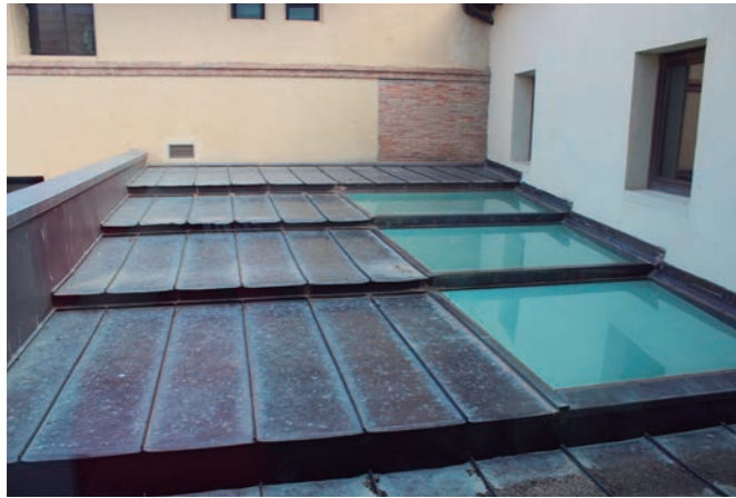
Figura 68. Cubierta de la pasarela de conexión.
