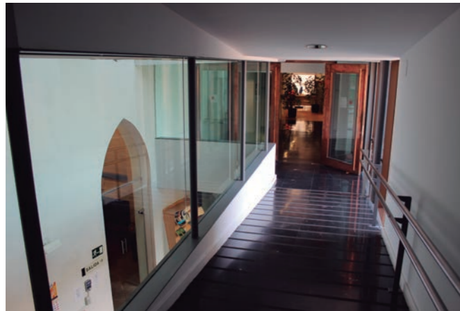
Figura 70. Pasarela de conexión.
