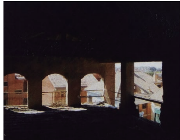
Figura 94. Espacio bajocubierto antes.
