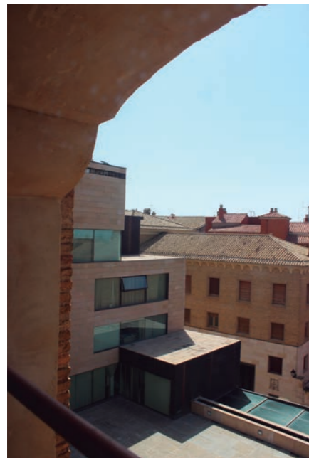
Figura 75. Fachada oeste ampliación.
