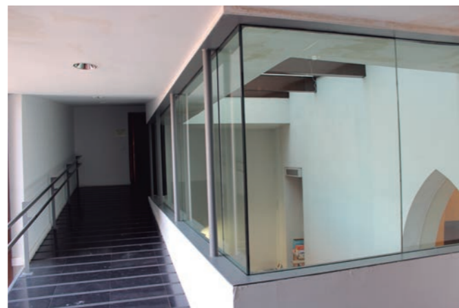
Figura 71. Pasarela de conexión.
