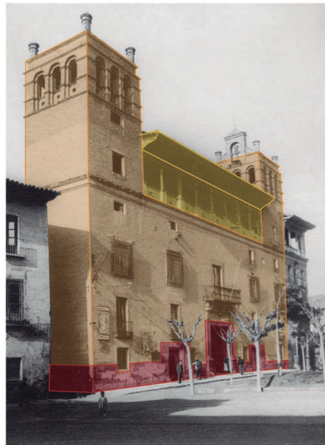
Figura 22. Aspecto de la fachada de Hernando Abadía. Destacan tres cuerpos: un zócalo de piedra, un paño de fachada de ladrillo y un mirador de alero de madera.
