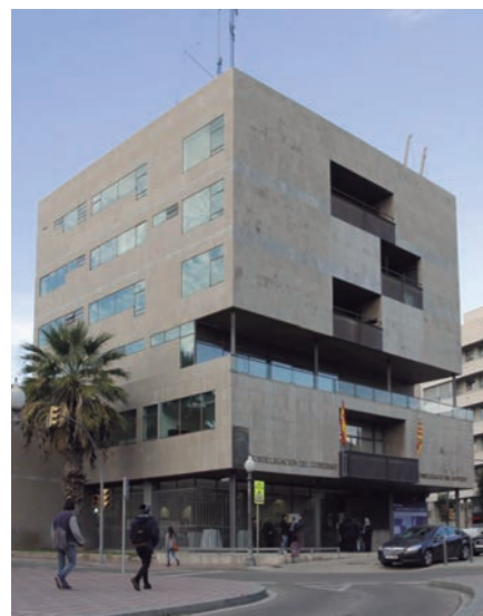
Figura 77. Fachada Gobierno Civil Tarragona, A. De la Sota.
