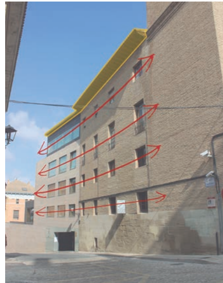
Figura 73. Fachada sur ampliación.
