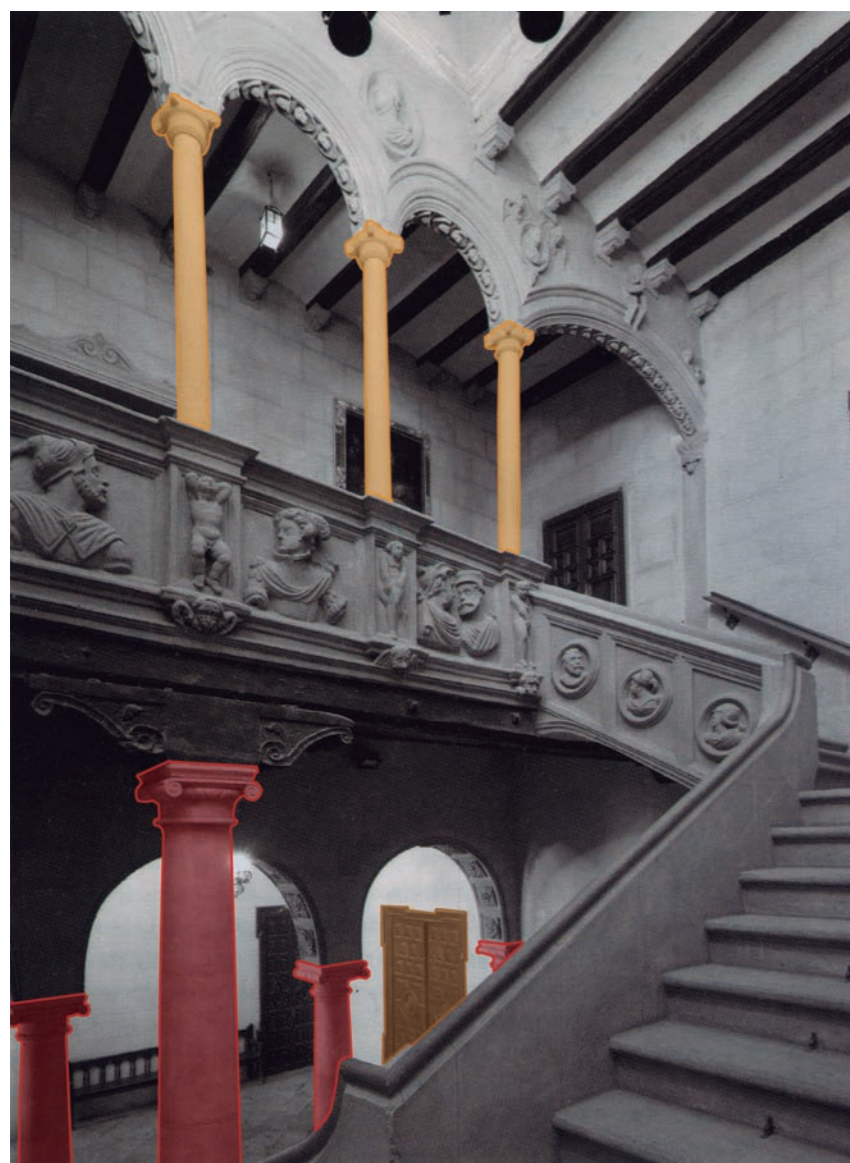
Figura 11. Escalera de tres tramos. Figura 12. Caja de la escalera de la intervención de Miguel Altué. Se identifican de abajo a arriba: -Tres columnas y dos pilastras (Rojo) -Tribunal de Justicia y puerta de la retreta baja (Marrón) -Arquillos (Amarillo)
