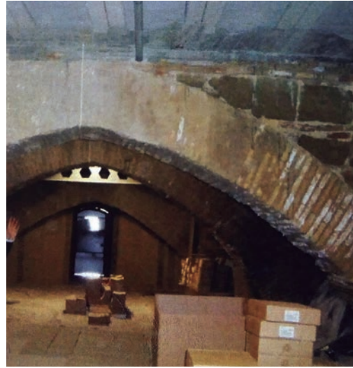
Figura 85. Espacio sótano antes.
