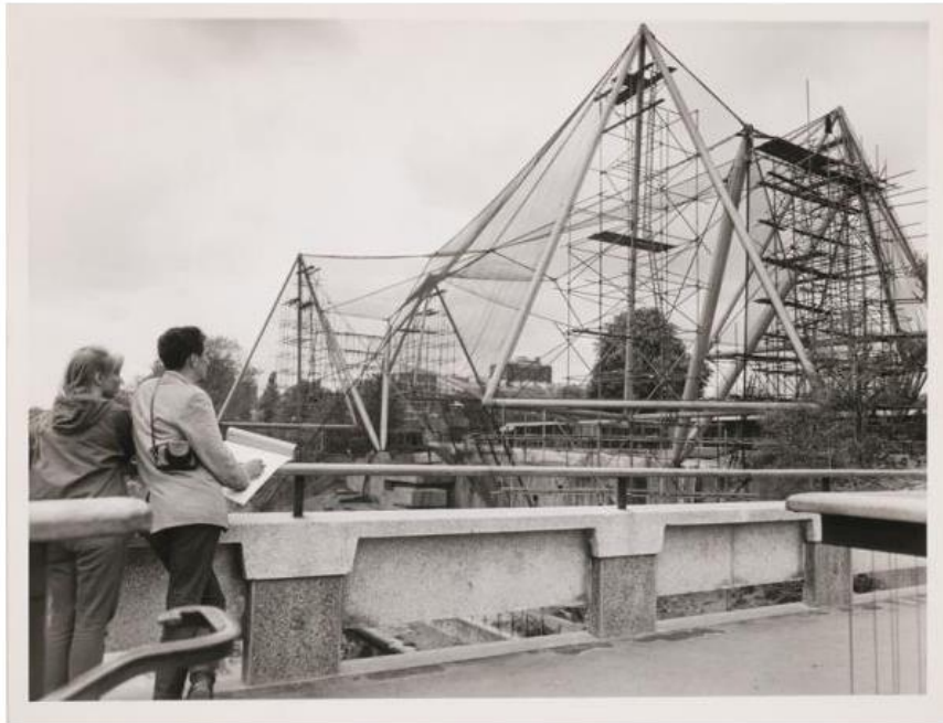
[f34] VISTA EN CONSTRUCCIÓN – LONDON ZOO AVIARY, 1960-1965
