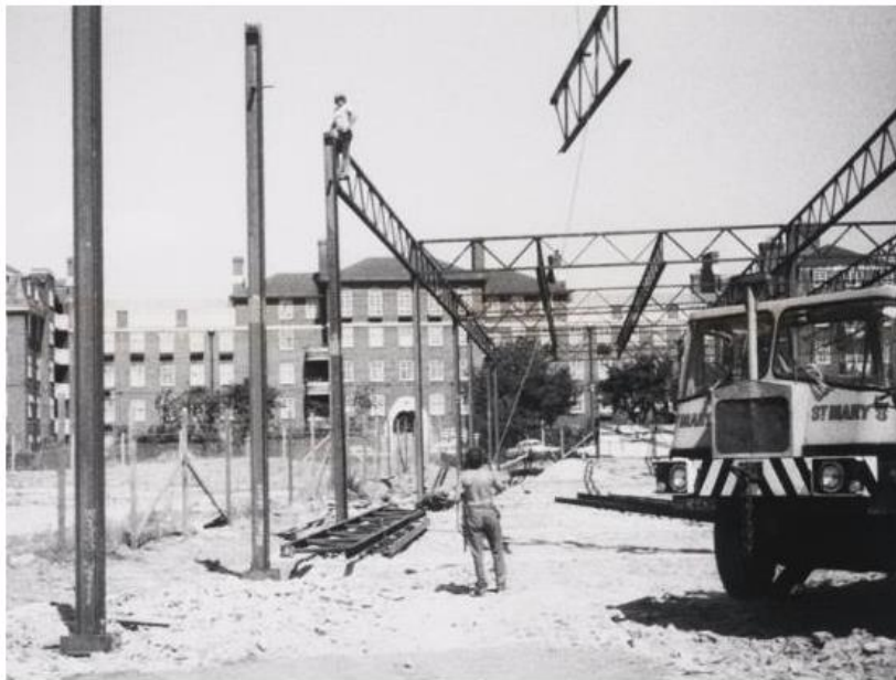
[f35] VISTA EN CONSTRUCCIÓN – INTER-ACTION CENTRE, 29 julio 1974
