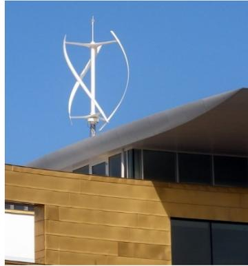
Fig. 42 Energía eólica doméstica - Fuente: Anders Sandberg, "Vertical axis wind turbine"
