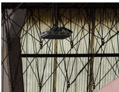
F.46, Imagen de los cables de la contracatenaria destensados, debido a que en el momento de la instantánea no había viento.
