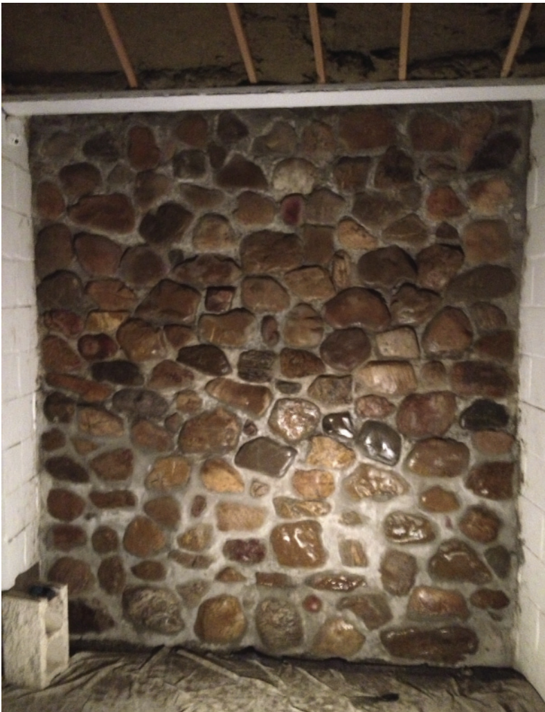
Construcción de pared de piedra natural
