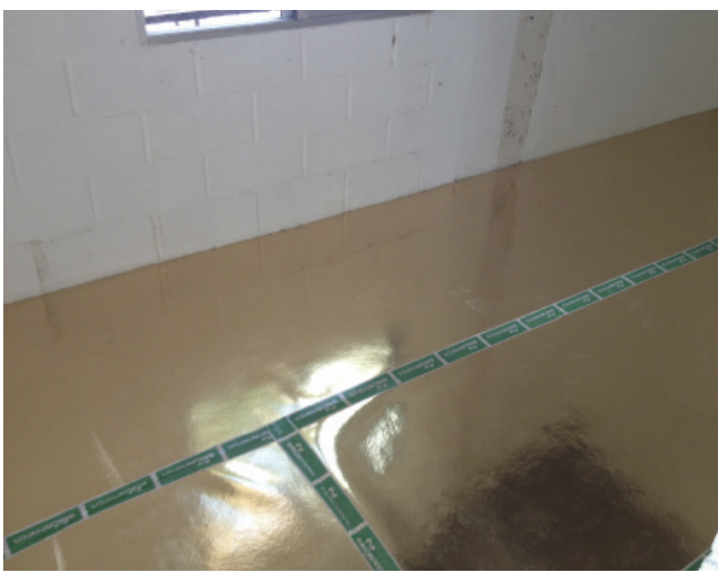
Colocación de base niveladora de irregularidades, ignífuga y disipadora electrostática.
