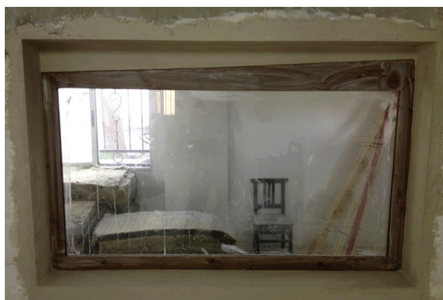
Construcción de pecera
