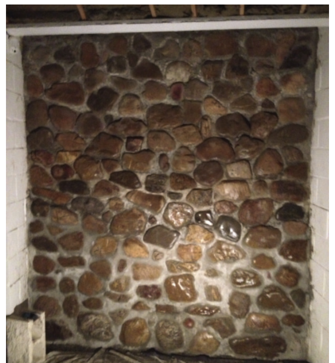
Limpieza de la piedra y barnizado
