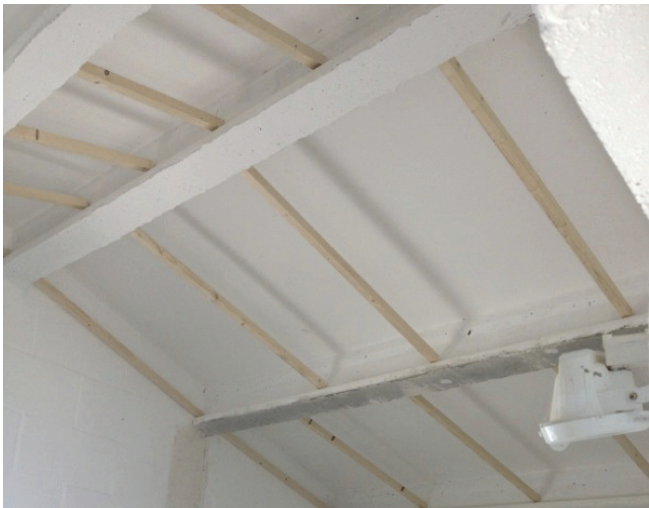
Colocación de los rastreles de pino sobre las vigas.
