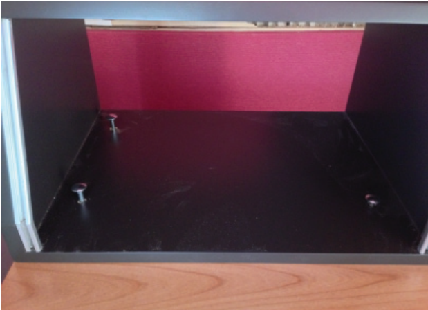
Módulo superior con tornillos pasantes.
