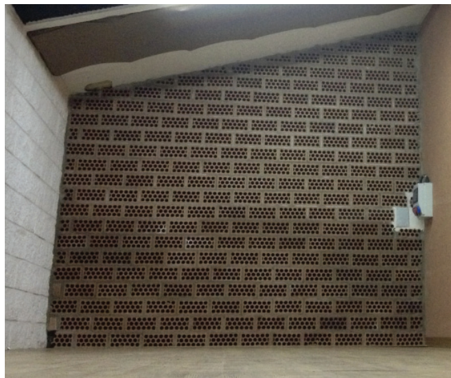
Levantamiento de muro
