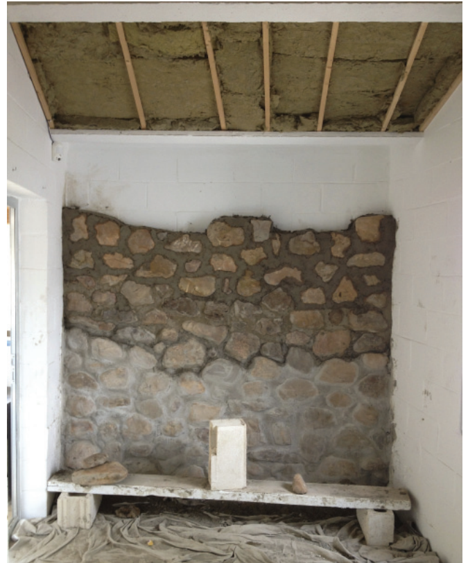
Colocación de la piedra en 3 fases
