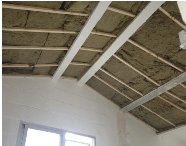
Relleno del interior con fibra a modo de absorbente y acondicionamiento acústico
