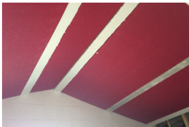
Instalación los bastidores terminados
