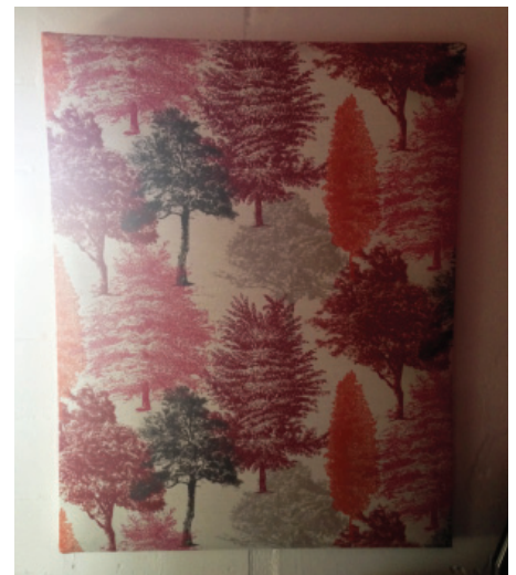
Detalle de marco difusor revestido como cuadro. El motivo elegido para el entelado aporta calidez al estudio y está elegido para funcionar en la misma gama de colores empleada para el forrado de bastidores en techo y pared frontal.
