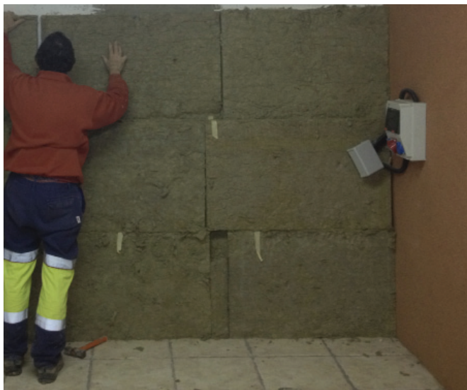
Colocación de material absorbente en planchas
