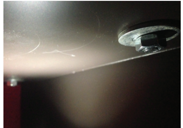
Unión interior con tornillo pasante, tuerca y arandela
