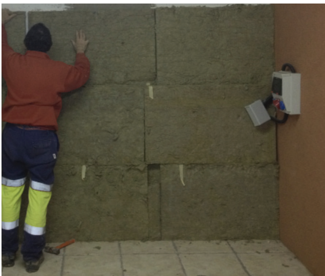
Colocación de absorbente en planchas
