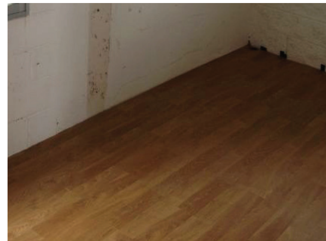
Colocación de suelo laminado
