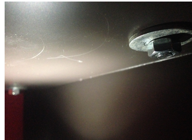
Unión interior con tornillo pasante, tuerca y arandela para fijación
