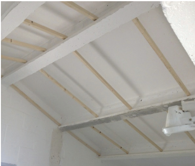
Colocación de los rastreles de pino sobre las vigas.
