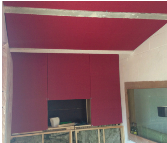
Colocación de bastidores entelados sobre la estructura
