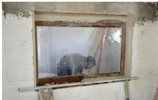
Marcado para instalación de la pecera
