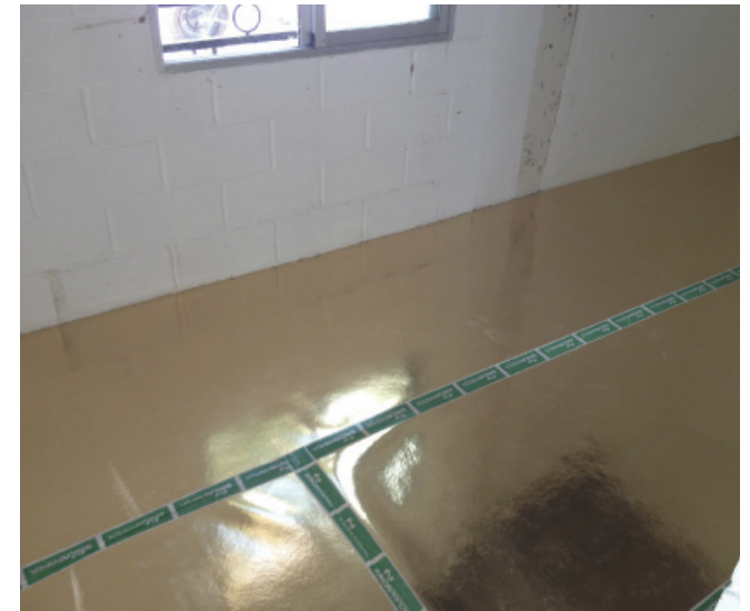
Colocación de base niveladora de irregularidades, ignífuga y disipadora electrostática.
