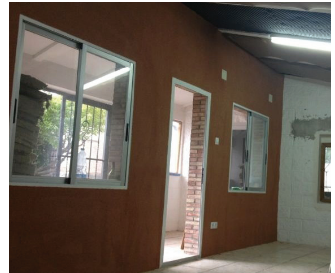
Revestimiento de pared con moqueta como absorbente
