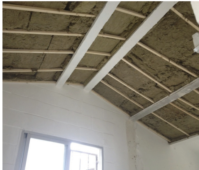
Relleno del interior con fibra a modo de absorbente y acondicionamiento acústico.
