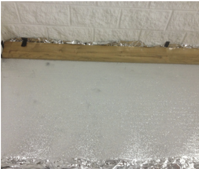
Colocación de aislante para pavimento
