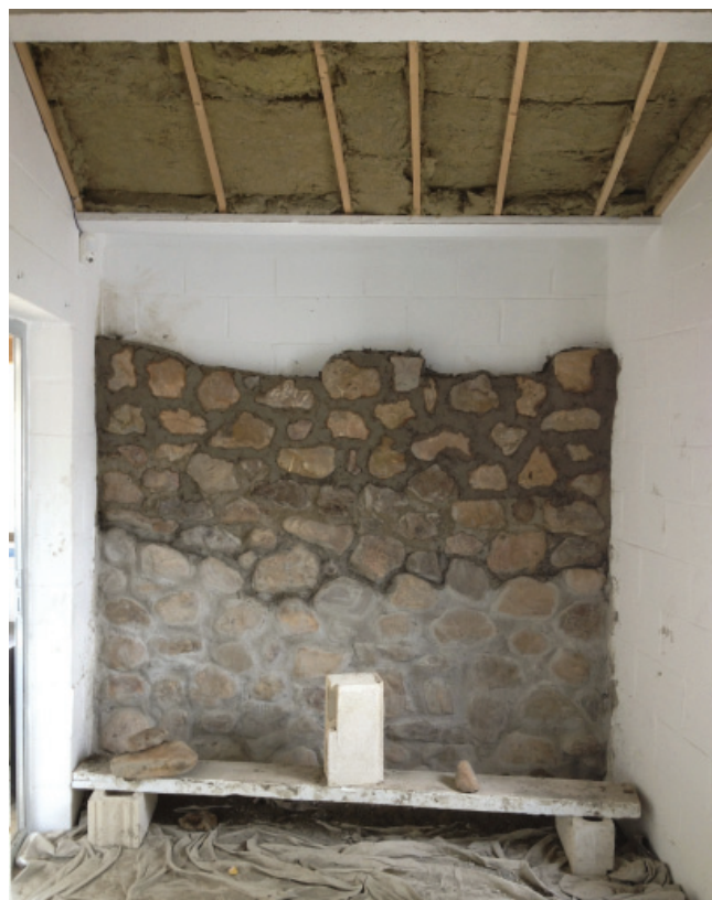
Colocación de la piedra en 3 fases
