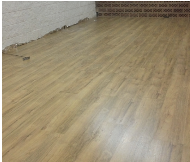
Instalación de suelo laminado
