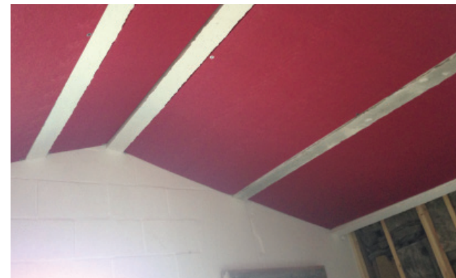
Colocación de respaldos y marcos difusores
