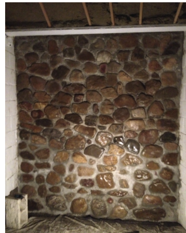
Limpeza de la piedra y barnizado
