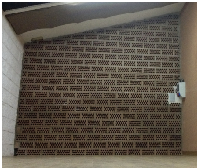
Levantamiento de muro
