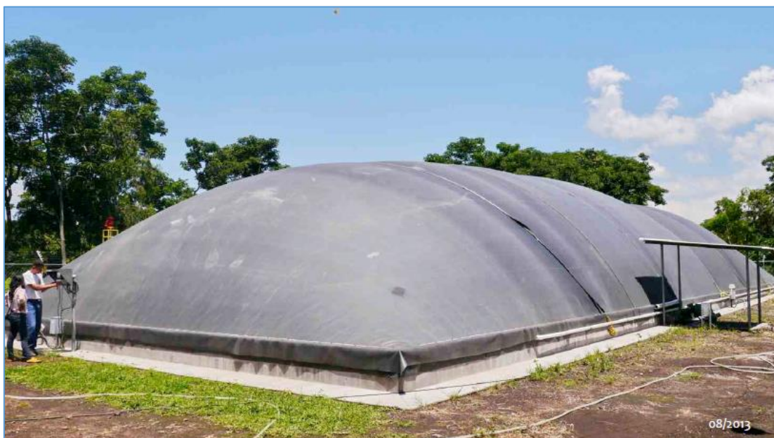
Ilustración 26: Biodigestor en Funcionamiento Fuente: Aqualimpia
