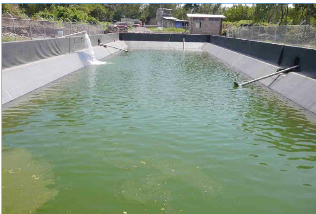
Ilustración 24: Llenado de la Laguna Anaerobia con las Excretas Animales Previamente Mezcladas Fuente: Aqualimpia
