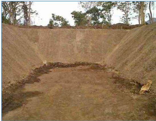
Ilustración 20: Excavación del Biodigestor Fuente: Aqualimpia
