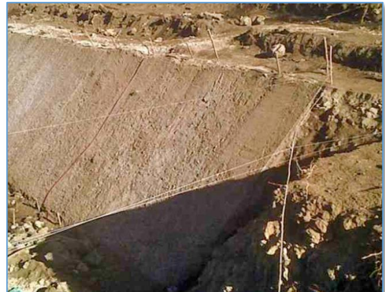
Ilustración 21: Estabilización de Taludes Fuente: Aqualimpia
