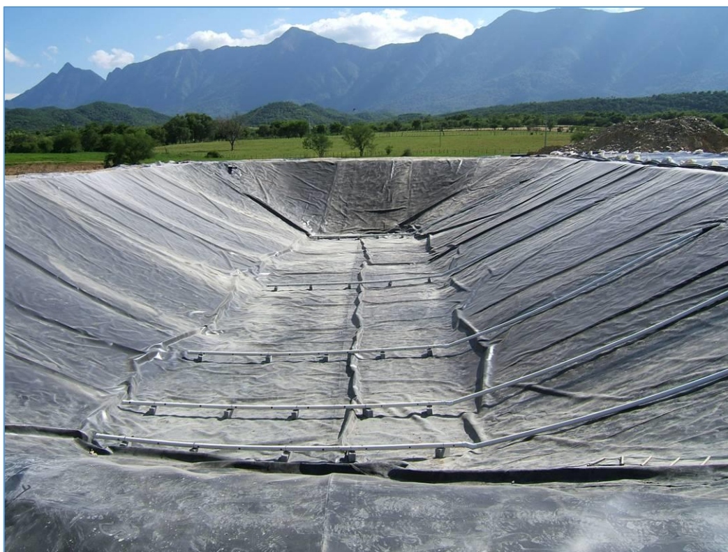
Ilustración 23: Revestimiento del Biodigestor con Membrana de Polietileno de Alta Densidad HDPE Fuente: Fideicomiso de Riesgo Compartido de México
