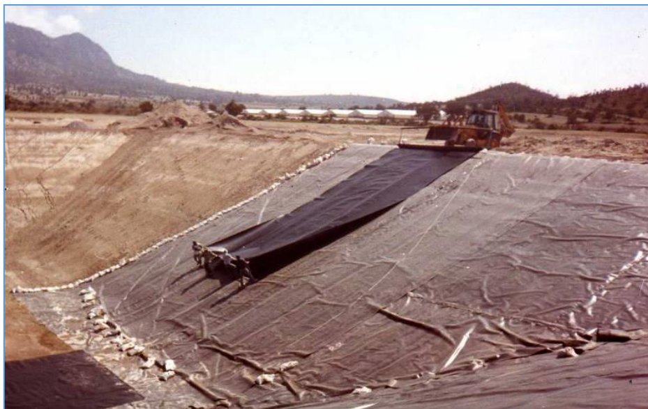
Ilustración 22: Colocación de Geotextil para el Reforzamiento y Protección de la Geomembrana Fuente: Secretaría de Agricultura, Ganadería, Desarrollo Rural, Pesca y Alimentación
