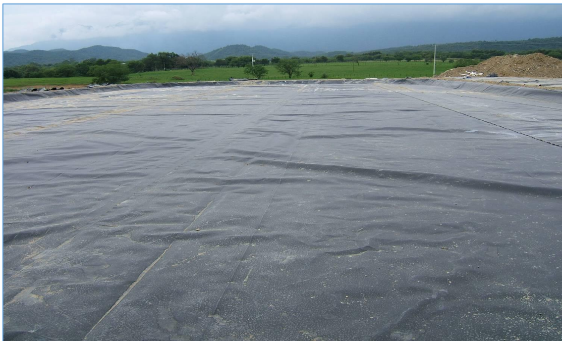
Ilustración 25: Instalación de la Cubierta del Biodigestor tras el Llenado de la Laguna Fuente: Secretaría de Agricultura, Ganadería, Desarrollo Rural, Pesca y Alimentación
