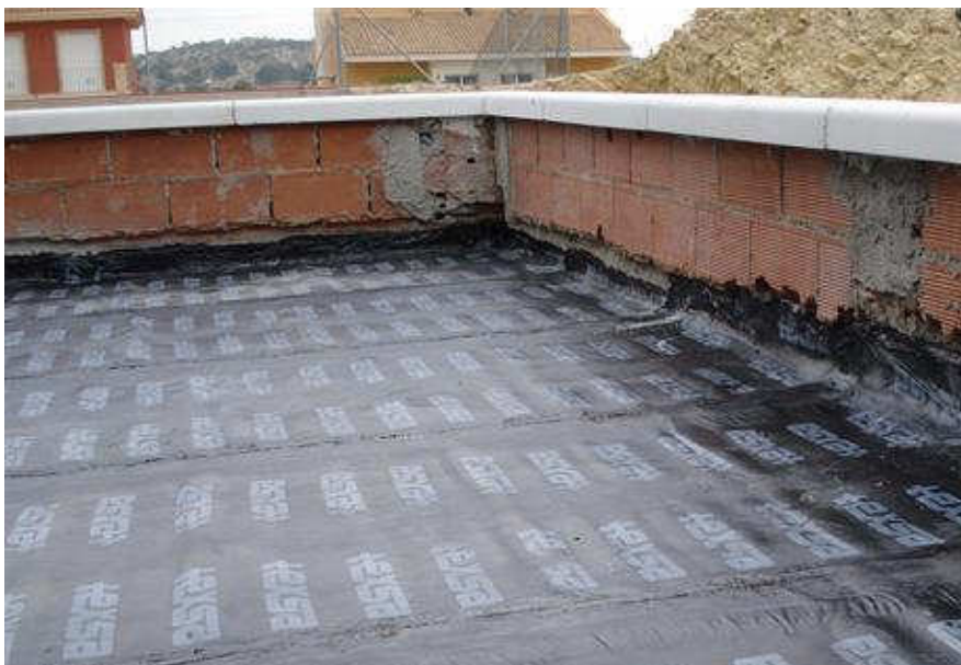
5- Ejemplo de cubierta completamente impermeabilizada.
