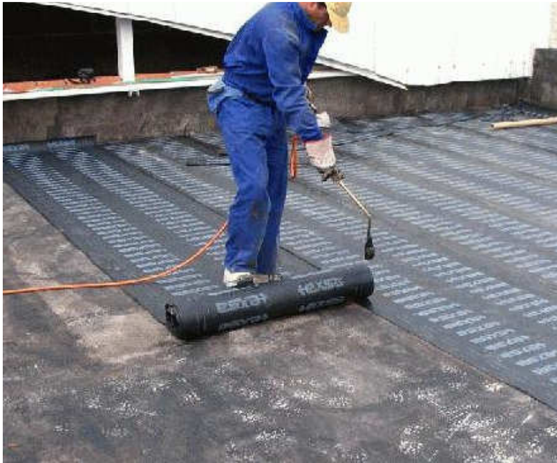
4- Aplicación de la lámina impermeable mediante soplete.
