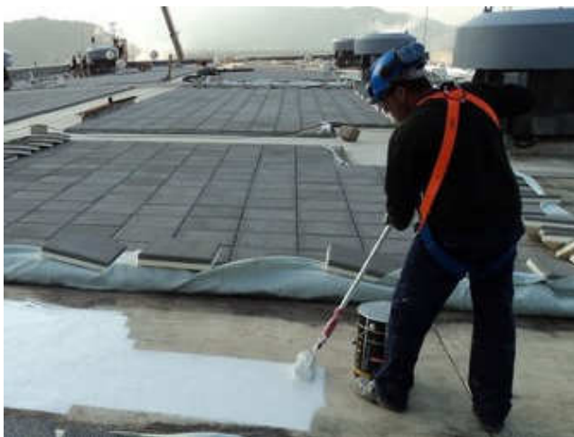
3- Aplicación de imprimación asfáltica previa a la impermeabilización.
