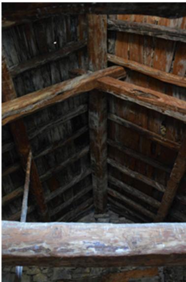
Fig 51 - La falsa / Estructura de cubierta
