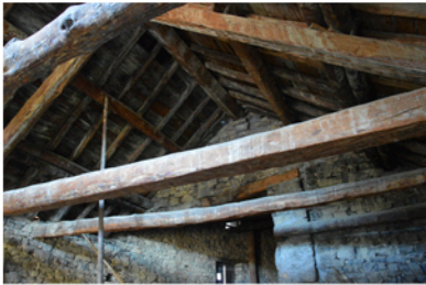
Fig 74 - Estructura de cubierta
