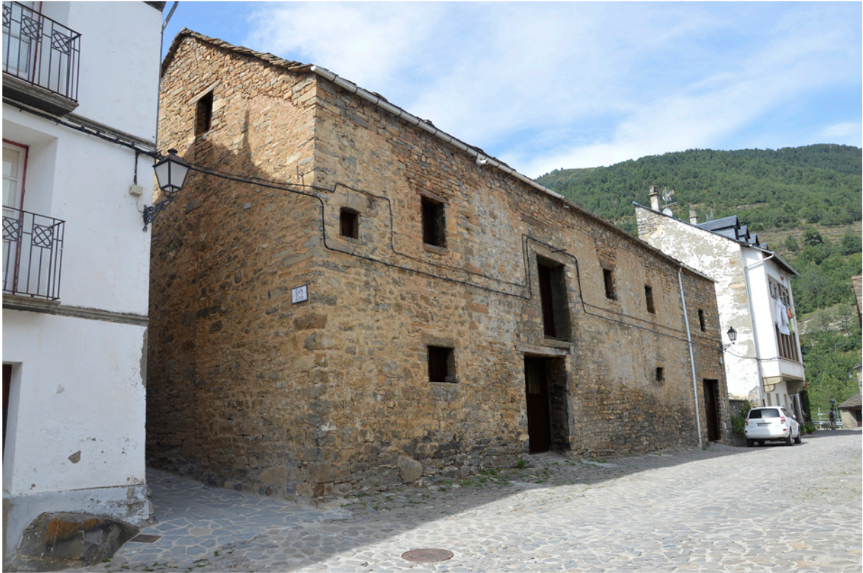
Fig 68 - Composición irregular de los vanos
