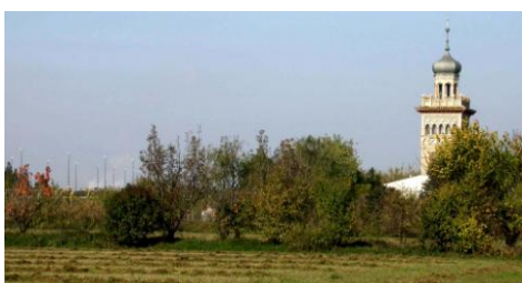
[Figura 7. Torre Virreina, Movera Fuente: panoramio]
