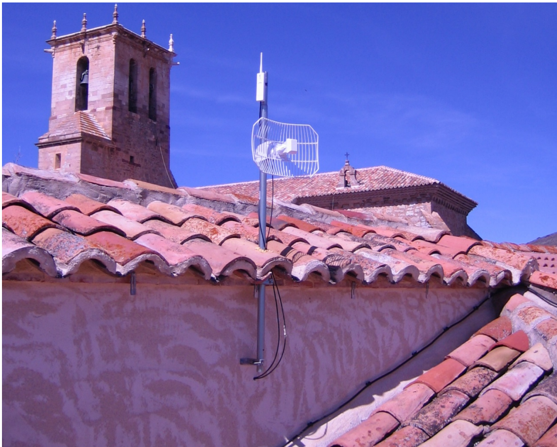
Figura 17: Antenas PicoStation M y AirGrid M2HP situadas en el Ayuntamiento de Alustante.
