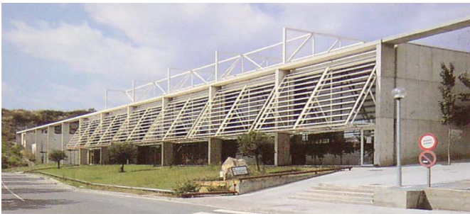
4_12 Parasol del Pabellón de Montgat.
