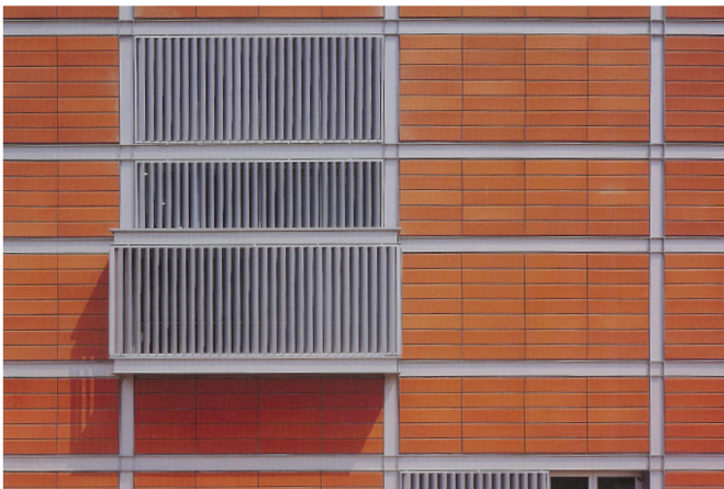
5_19 Vista del hueco.
