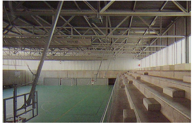
4_04 Entrada de luz, Pabellón de Valdemoro.
