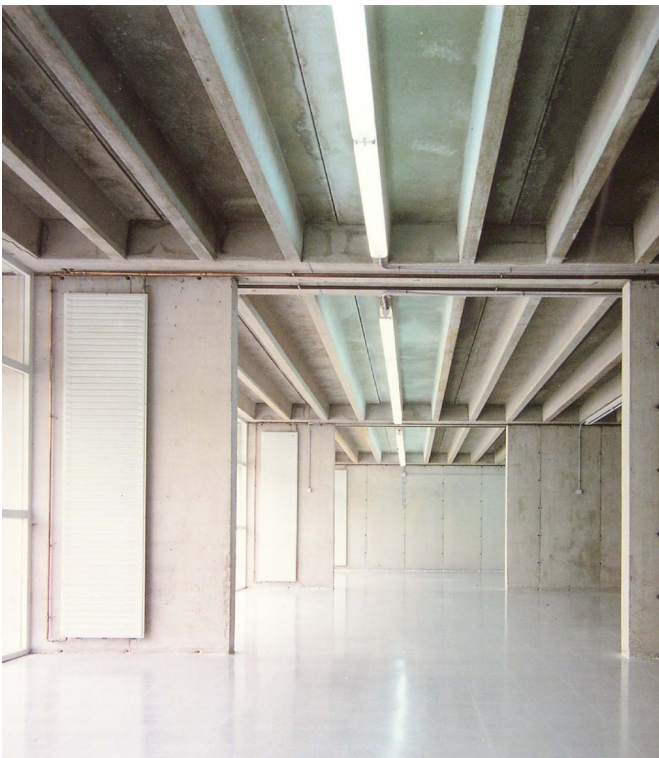
4_10 Construcción con prefabricados, Pabellón de Montgat.
