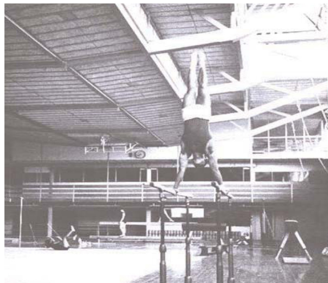
1_04 Gimnasio del colegio Maravillas, Alejandro de la Sota. Madrid, 1962.
