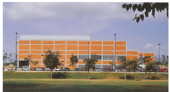
5_14 Vista exterior de la estructura.
