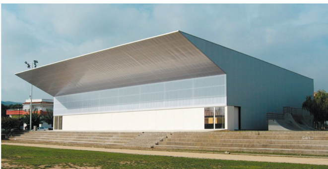
4_13 Voladizo del Pabellón de Palafolls.
