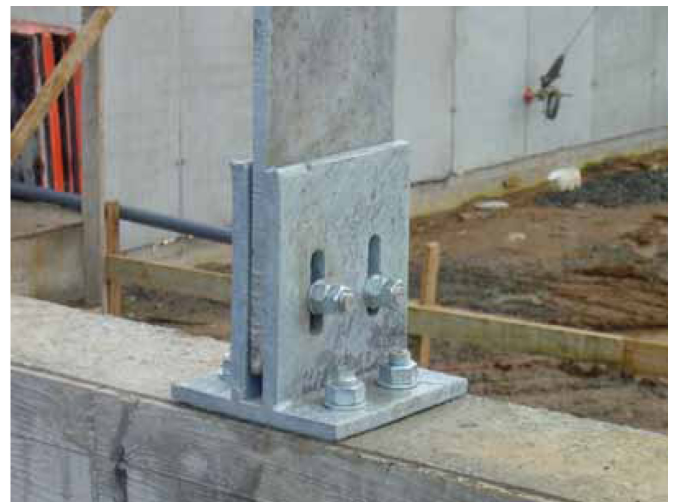
4_09 Unión atornillada, estructura del Pabellón de Guntfín.
