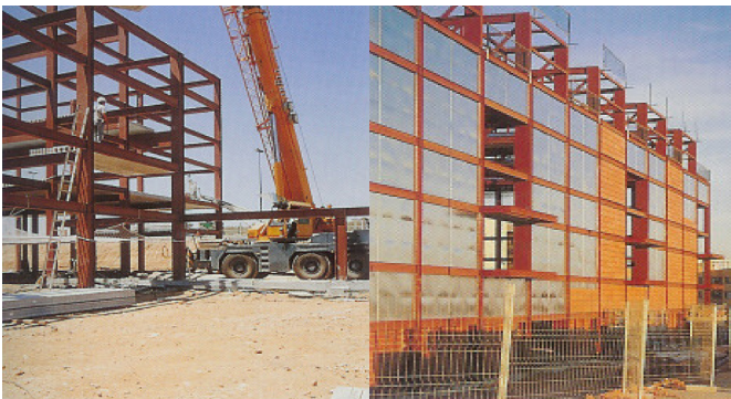
5_16 Construcción de la estructura.
