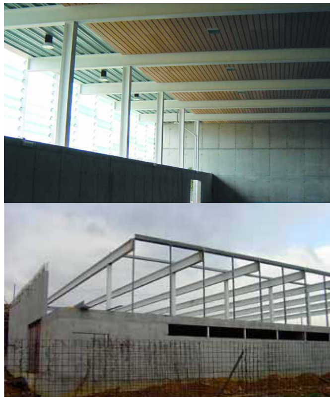
3_31, 3_32 Estructura, Pabellón de Guntín.
