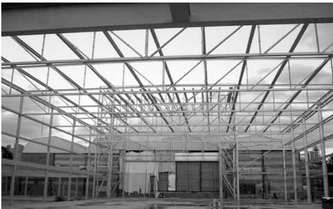
3_40 Construcción estructura, Pabellón Oli.
