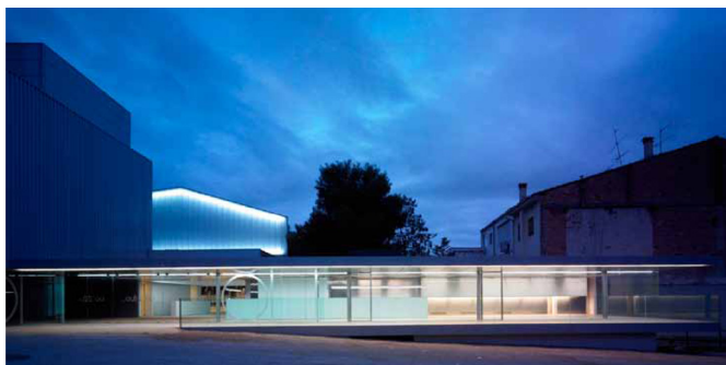
4_08 Grandes superficies vidriadas, Pabellón de Oli.
