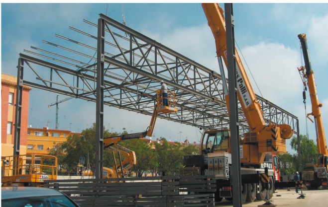
3_41 Construcción estructura, Pabellón Palafolls.
