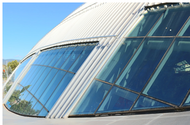
42. Detalle exterior cubierta
