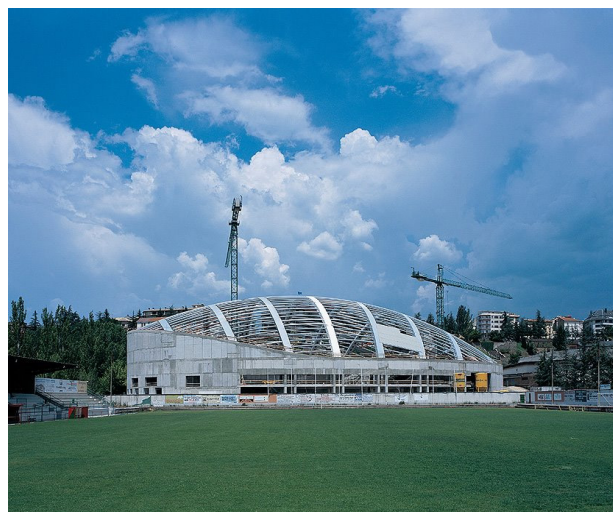
36. Detalle del cuerpo estructural del edificio durante su construcción.
