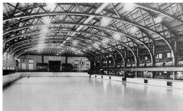
3. Elysium Rink, Cleveland. Primera pista de hielo construida sobre una base de hormigón permanente.
