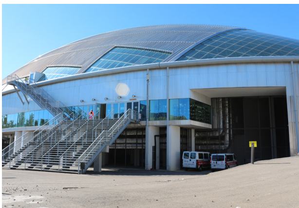
46. Vista exterior del Pabellón desde la parte trasera, donde quedan a la vista todas las posibilidades de cerramientos utilizados.
