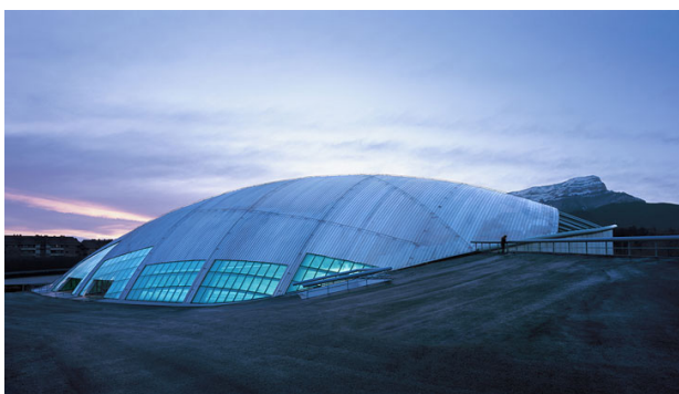
40. Vista exterior de la cubierta
