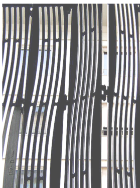
Celostia de hierro fundido de la fachada
