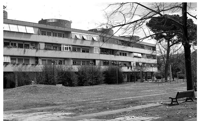
4.02.06. Edificio de tipología "A" en el que las terrazas vuelcan sobre un amplio espacio verde.
