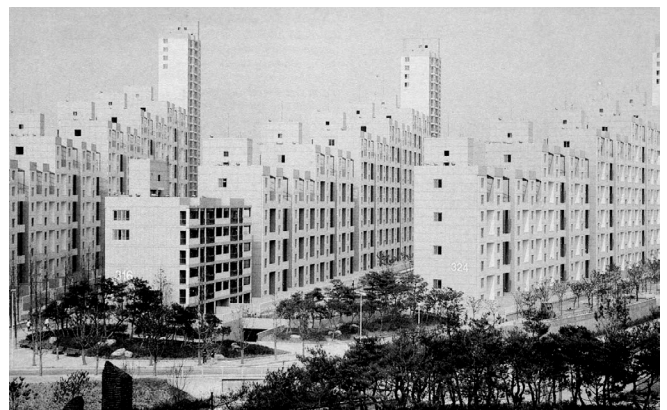
3.08. Viviendas escalonadas en la villa olímpica de los Juegos Olímpicos de Seúl en 1988.
