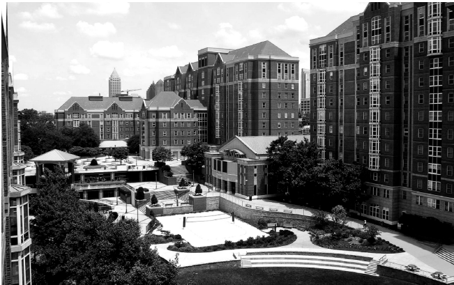
4.08.02. Imagen del espacio público interior formado por los bloques residenciales.
