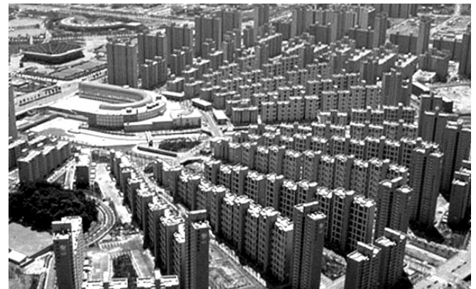
4.06.01. El conjunto residencial se dispone de forma radial convergiendo en el edificio principal de la villa olímpica.
