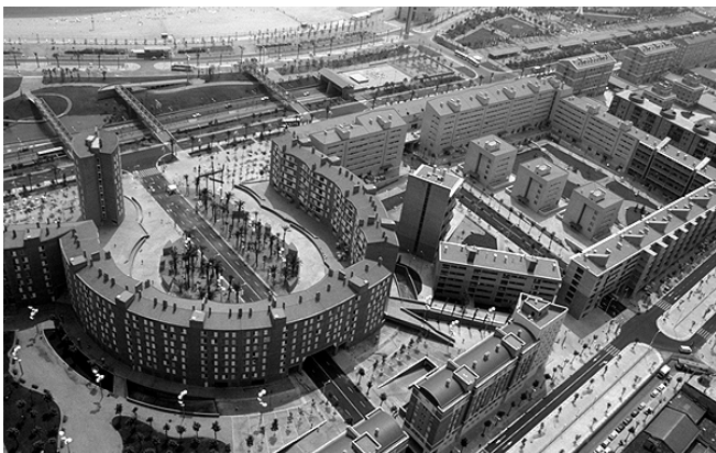
4.07.03. Vista aérea del nuevo tejido residencial en continuación con el Ensanche de Barcelona.
