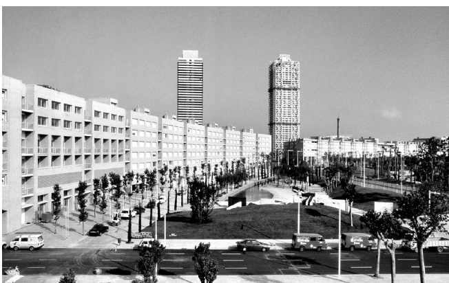
4.07.02. Nueva fachada del frente marítimo de la ciudad. De fondo, las dos torres que caracterizan la zona internacional.
