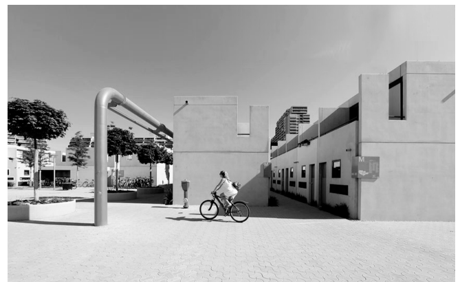
4.03.05. Vista del nivel peatonal en la villa olímpica de las mujeres. A la izquierda se observa el sistema estructural de Hans Hollein.
