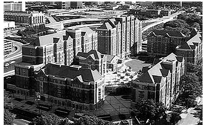
4.08.01. Complejo residencial en la villa olímpica de Atlanta que tras los Juegos forma parte de la red de residencias universitarias.
