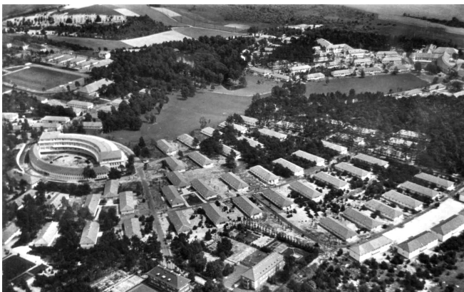
4.01.02. Vista del complejo residencial desde el lado noroeste del conjunto olímpico. Edificio de restauración a la izquierda.
