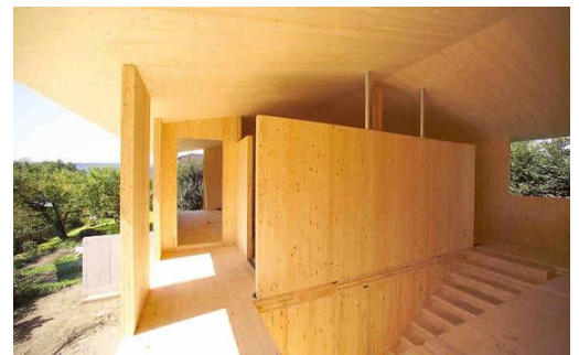
I. 20 Interior de una estructura de paneles CLT
