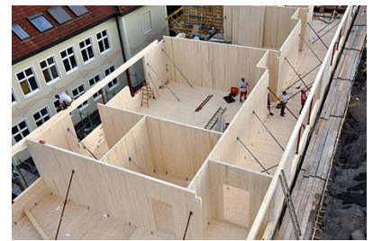
I. 10 Obra realizada con madera CLT
