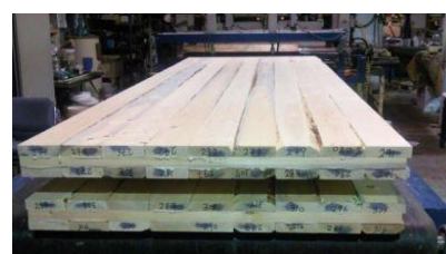
I. 15 Fabricación de los paneles
