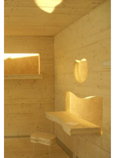
I. 44 Acabado visto del CLT
