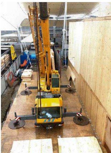
I. 42 Proceso de puesta en obra
