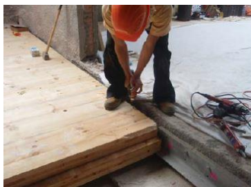
I. 35 Operario procediendo al anclaje de los paneles
