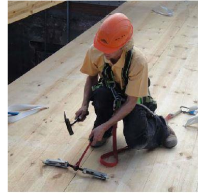
I. 36 Operario usando un sistema de seguridad anclado a los propios tableros
