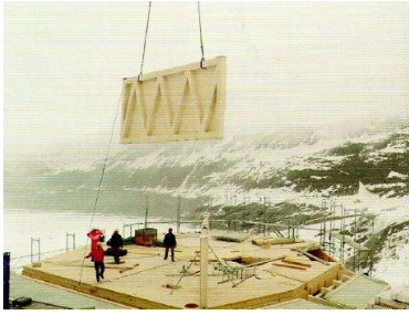
I. 55 Puesta en obra mediante helicóptero
