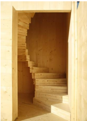
I. 50 Prototipo de escaleras diseñado para la torre
