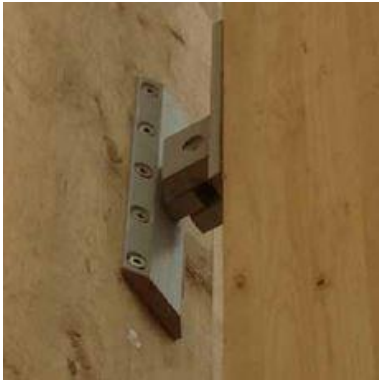
I. 41 Anclaje situado entre los pórticos y las cajas expositivas
