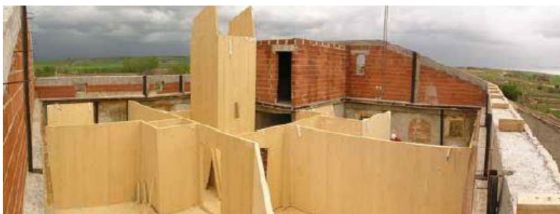
I. 22 Rehabilitación mediante paneles CLT. Hotel rural en Riahuelas
