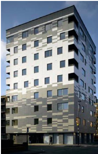
I. 59 Vista general del edificio Stadthaus, 24 Murray Grove
