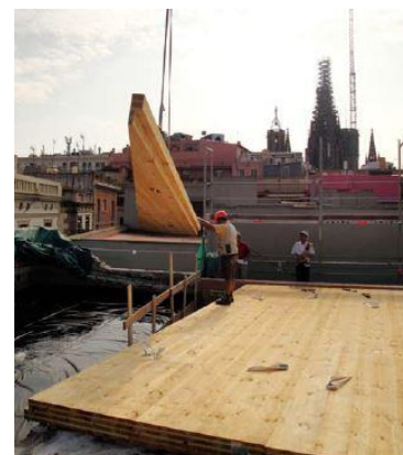
I. 31 Colocación de los paneles diseñados a medida
