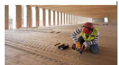
I. 27 Operario realizando conexiones entre paneles de un mismo forjado
