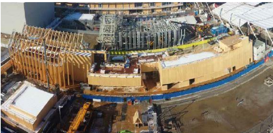
I. 43 Vista general de su construcción
