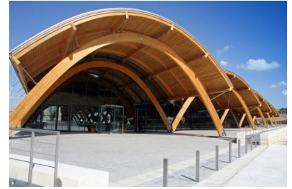
I. 9 Obra realizada con madera laminada
