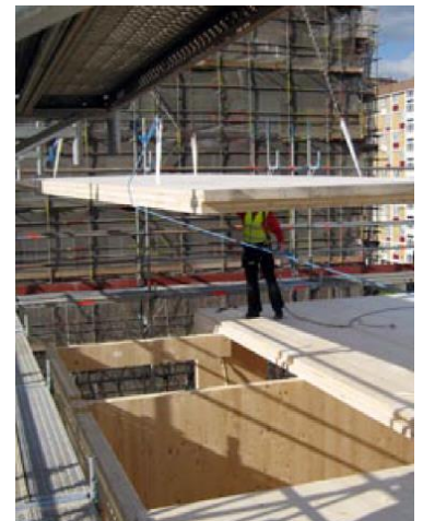
I. 62 Colocación de forjados mediante grua
