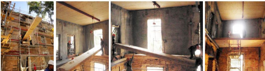
I. 71 Proceso de puesta en obra facilitado por las dimensiones de los paneles
