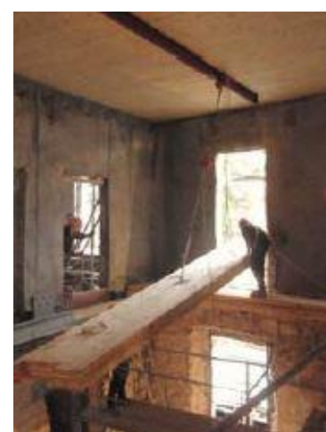
I. 32 Colocación en obra facilitada por las dimensiones de los paneles
