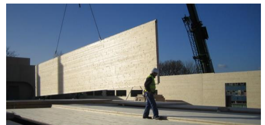
I. 21 Colocación en obra de un pael de grandes dimensiones
