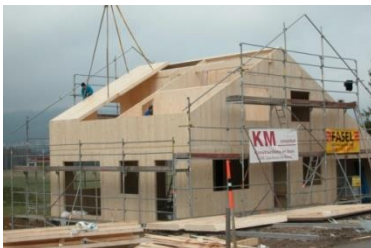
I. 4 Construcción con madera CLT
