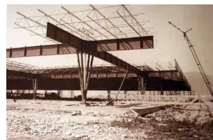
4.10 _ Estructura Pabellón Exposiciones Grenoble 1967. Estructura tipo taburete
