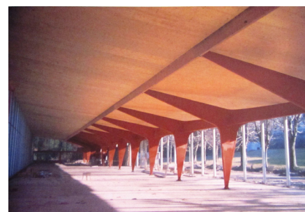
4.8 _ Nave para Evian 1956. Estructura tipo muleta
