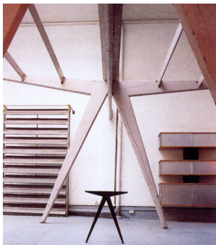
3.47 _ Estructura Pórtico para marquesina en Le Mans (1954) comparada con la de la silla Compás de (1948)
