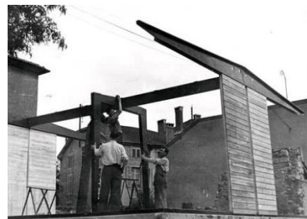
3.49 _ Construcción Maison Démontable 6x6. Estas estructuras de barracones se construía en un día y sólo hacían falta 2-3 personas. Años 40
