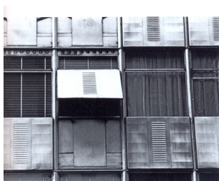
3.29_ Fachada aluminio móvil para Edificio Mozart 1953
