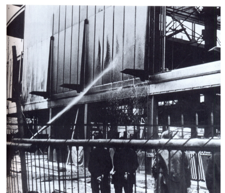
2.11 _ Pruebas fachada impermeable en la Maison du peuple de Clichy (1935)
