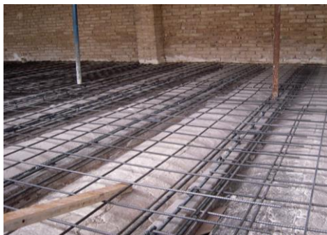
Figura 14: capa de compresión sobre bovedillas cerámicas y vigería de madera.
