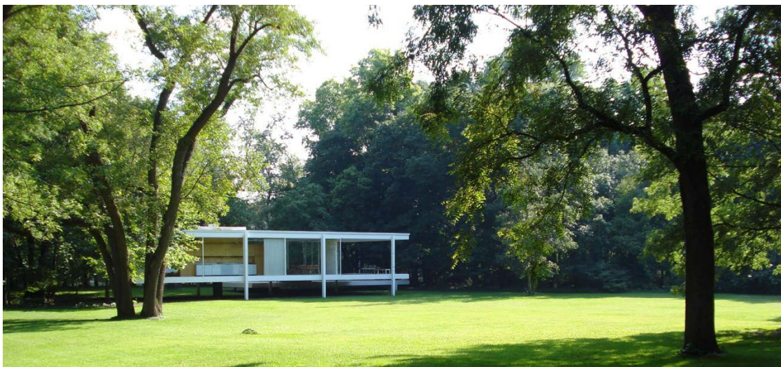
Figura 10. Perspectiva desde la carretera de entrada a la Casa Farnsworth.
