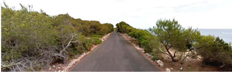
Figura 7. Carretera Santanyí-Alqueira Blanca.
