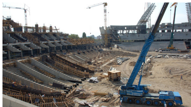
[5.14] Vigas de graderío de hormigón in situ a la espera de colocar los elementos de graderío prefabricados en el estadio Allianz Arena. Munich, 2005.
