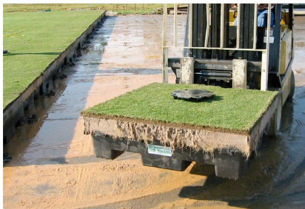
[3.06] Colocación del sistema modular del césped natural.
