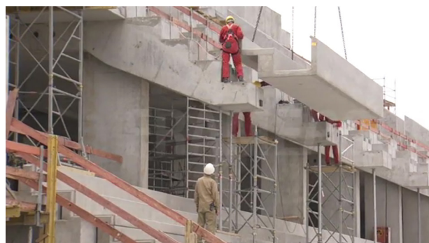
[5.15] Colocación de los elementos de graderío prefabricados sobre las vigas de graderío de hormigón in situ en el estadio Allianz Arena. Munich, 2005.
