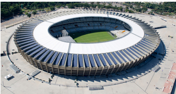
[4.31] Vista del terreno de juego en el nuevo estadio de Mineirão. Belo Horizonte, 2013.
