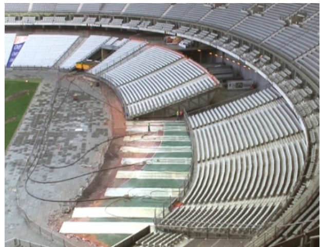
[4.07] Extracción de uno de los módulos en que se divide la tribuna inferior en el estadio Stade de France. París, 1995.
