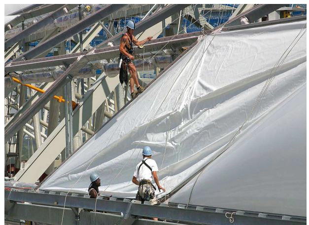
[5.22] Vista del anclaje de las almohadillas hinchables de ETFE a la subestructura de fachada.
