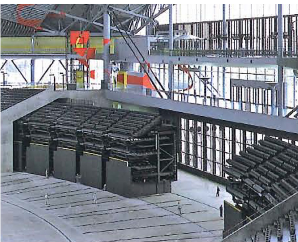
[4.17] Vista del proceso del graderío retráctil en el estadio Sapporo Dome. Sapporo, 2001.
