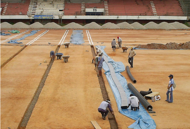
[3.13] Colocación del sistema de drenaje en un estadio de fútbol.
