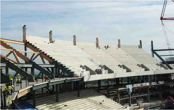
[3.20] Ejemplo de estadio con estructura de acero y elementos de graderío de hormigón prefabricado.
