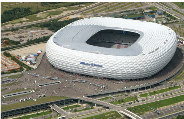
[5.30] Vista exterior de la cubierta translúcida (blanca) y transparente (gris) en el estadio Allianz Arena. Múnich, 2005.
