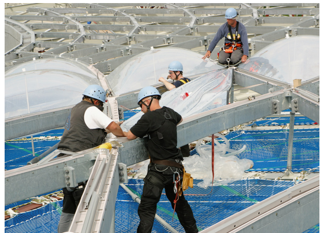
[5.21] Vista del anclaje de las almohadillas hinchables de ETFE a la subestructura de cubierta.
