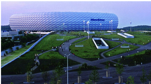
[5.09] Vista del acceso por la explanada sur en el estadio Allianz Arena. Múnich, 2005.
