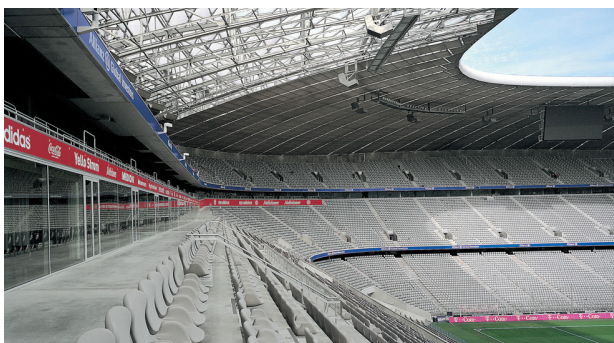
[5.11] Vista del terreno del graderío y terreno de juego en el estadio Allianz Arena. Múnich, 2005.
