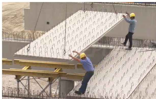
[5.12] Colocación de los graderíos prefabricados de hormigón sobre las vigas de graderío de hormigón in-situ en el estadio Allianz Arena. Munich, 2005.
