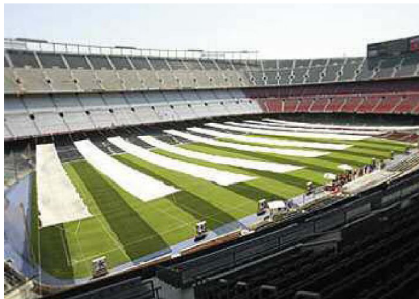
[3.19] Sistema de ventilación forzada del estadio Camp Nou. Barcelona, 1957.
