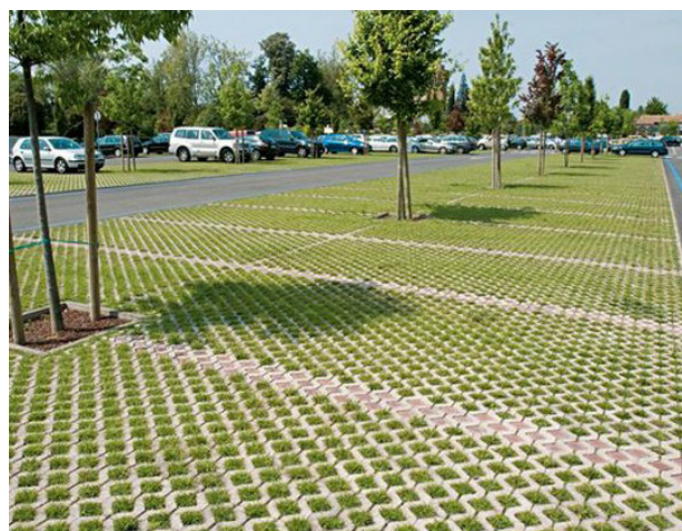
[4.22] Vista de pavimento permeable en el parking en el estadio de Frankfurt. Frankfurt, 2005.
